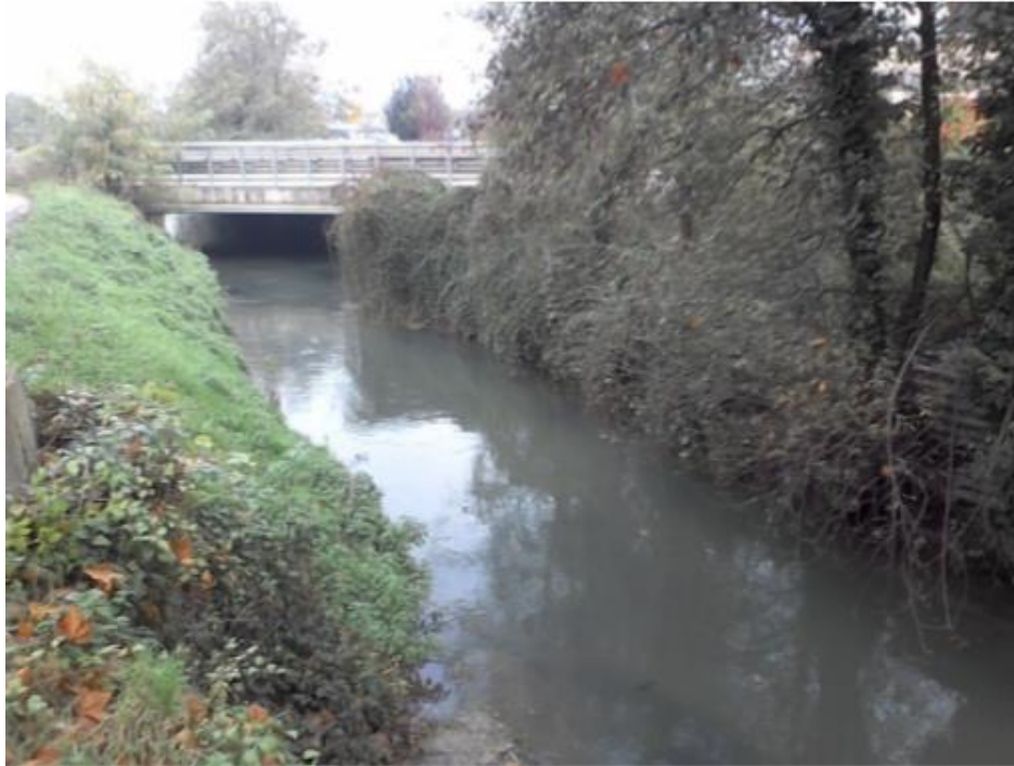
Vista verso NORD EST
