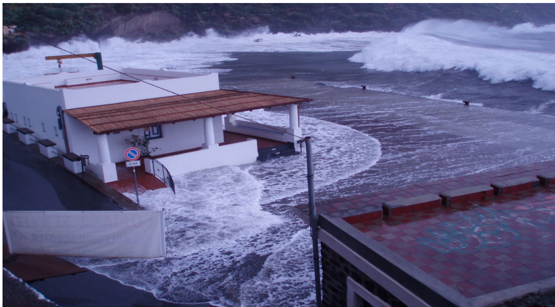
Figura 2.5 Inondazione banchina di riva e fabbricati prospicienti
