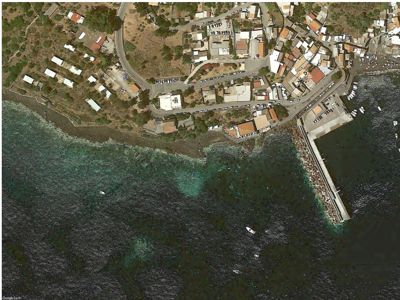
Vista aerea dell'area di intervento - ante operam
