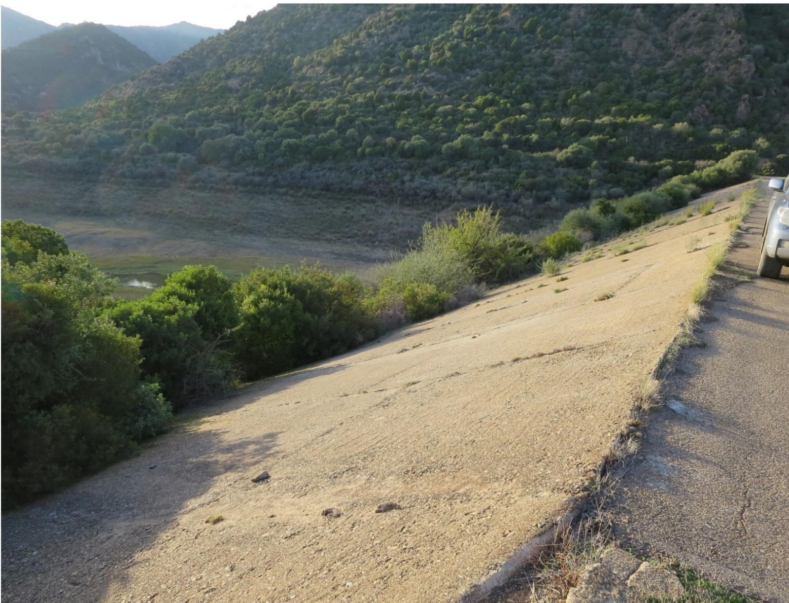
**Foto 9** (*particolare del rivestimento in calcestruzzo della parte superiore del paramento di monte*)
