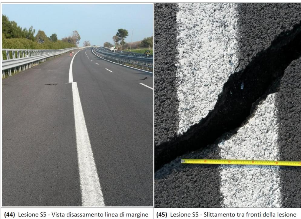
Figura 25: Viadotto Cacchione – Riattivazione 2015: Lesioni nella pavimentazione stradale nel tratto di rilevato/mezzacosta compreso tra il Viadotto Cacchione ed il Viadotto Marinella (Lesione “S5” in Carreggiata Nord a 55m circa dalla Spalla Bari del viadotto)
