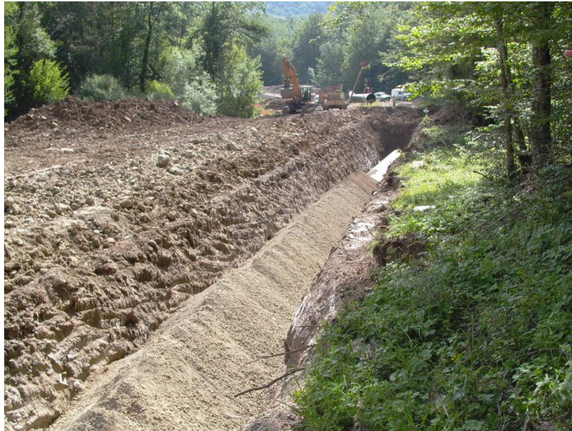
Figura 2-8 Rinterro della condotta
