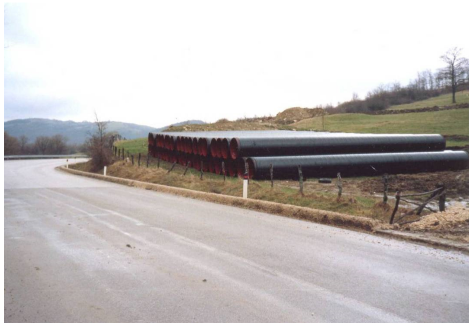
Figura 2-2 Foto tipica di una piazzola per accatastamento tubazioni
