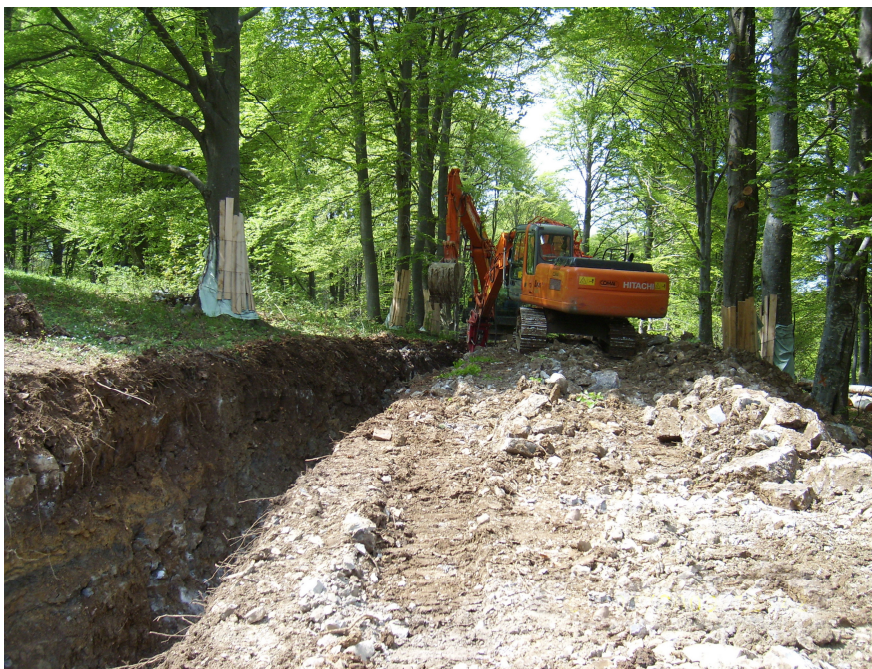
Figura 2-6 Foto tipica di scavo della trincea
