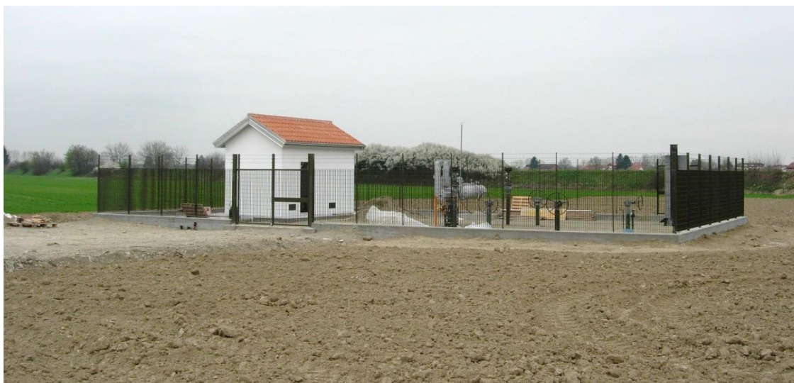
Figura 2-11 Esempio di Punto di intercettazione di linea (PIL) telecontrollato
