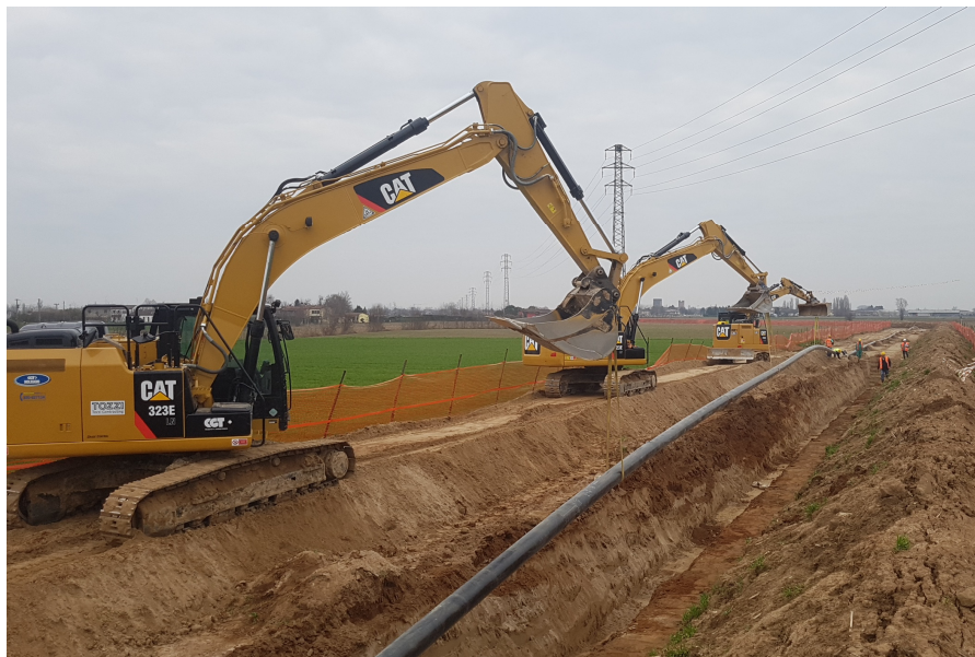
Figura 2-7 Posa della condotta
