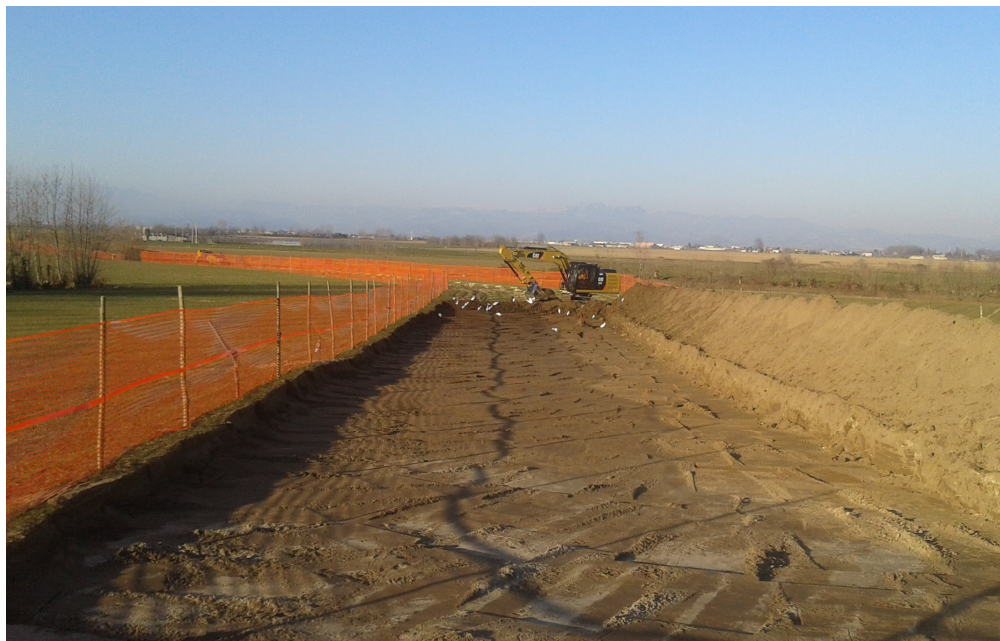
Figura 2-3 Foto di apertura della pista lavoro
