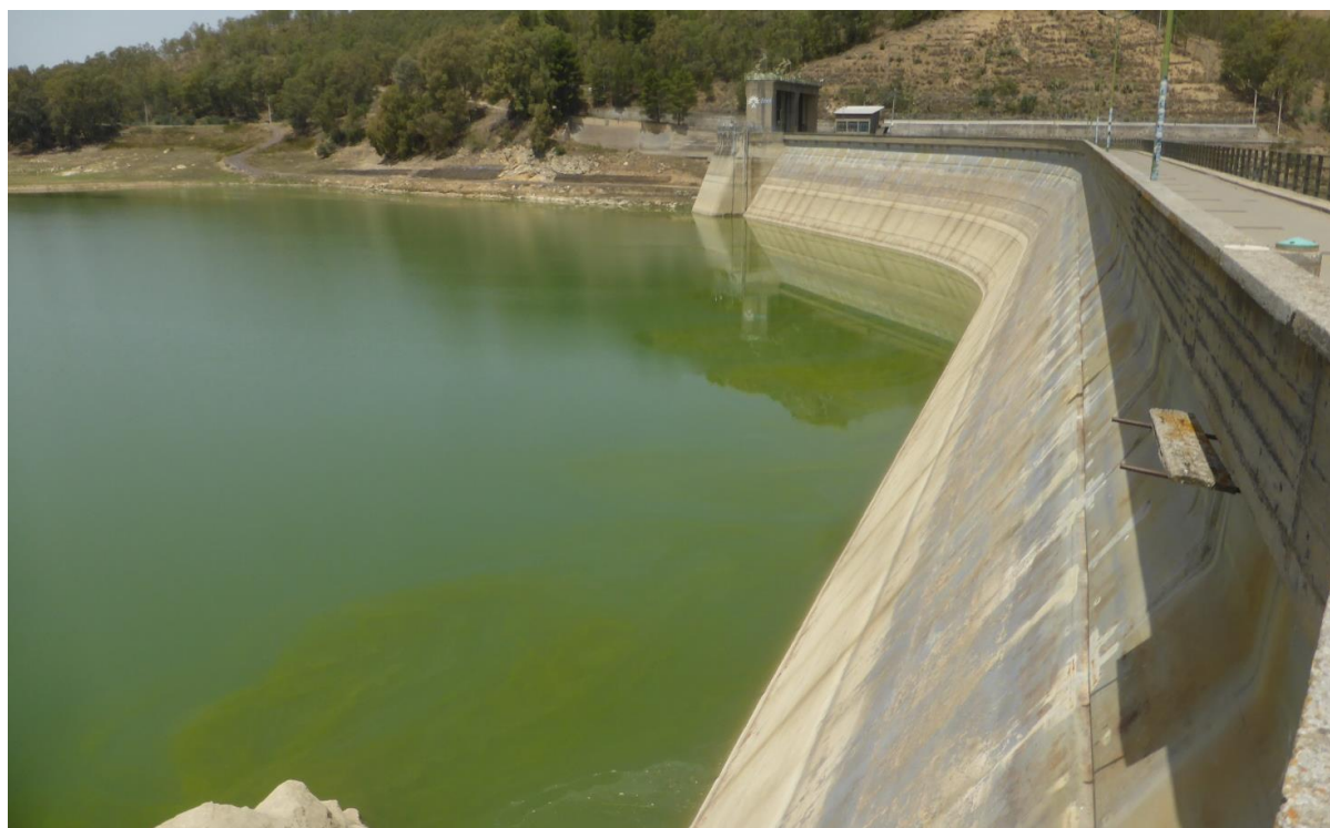
Figura 2-24. Diga del Pozzillo vista dal lato destro dell'invaso
