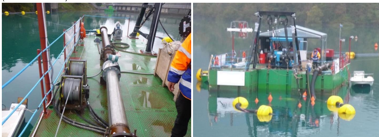
Figura 2-39. Esempio di cantiere
