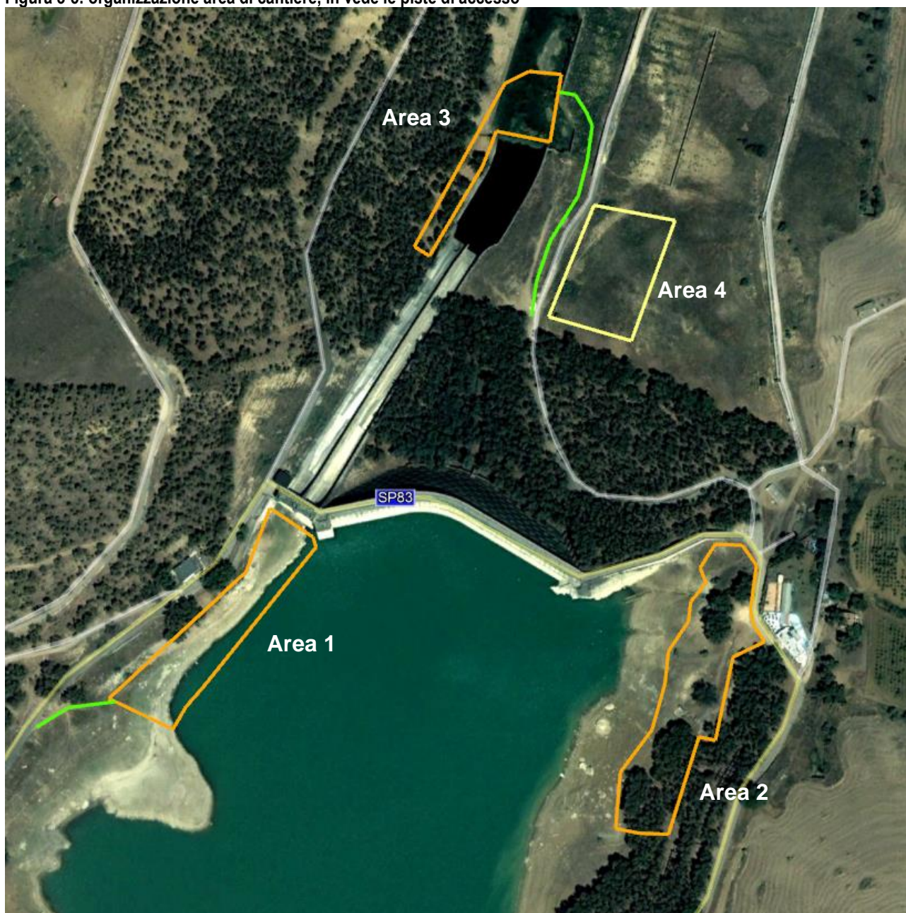
Figura 3-5: organizzazione area di cantiere, in vede le piste di accesso
