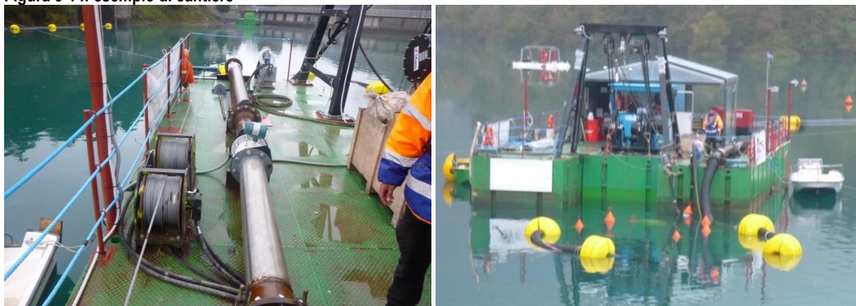
Figura 3-14: esempio di cantiere
