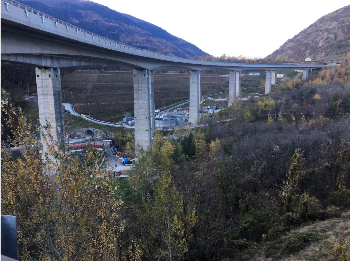
Figura 3 – Stato di fatto
