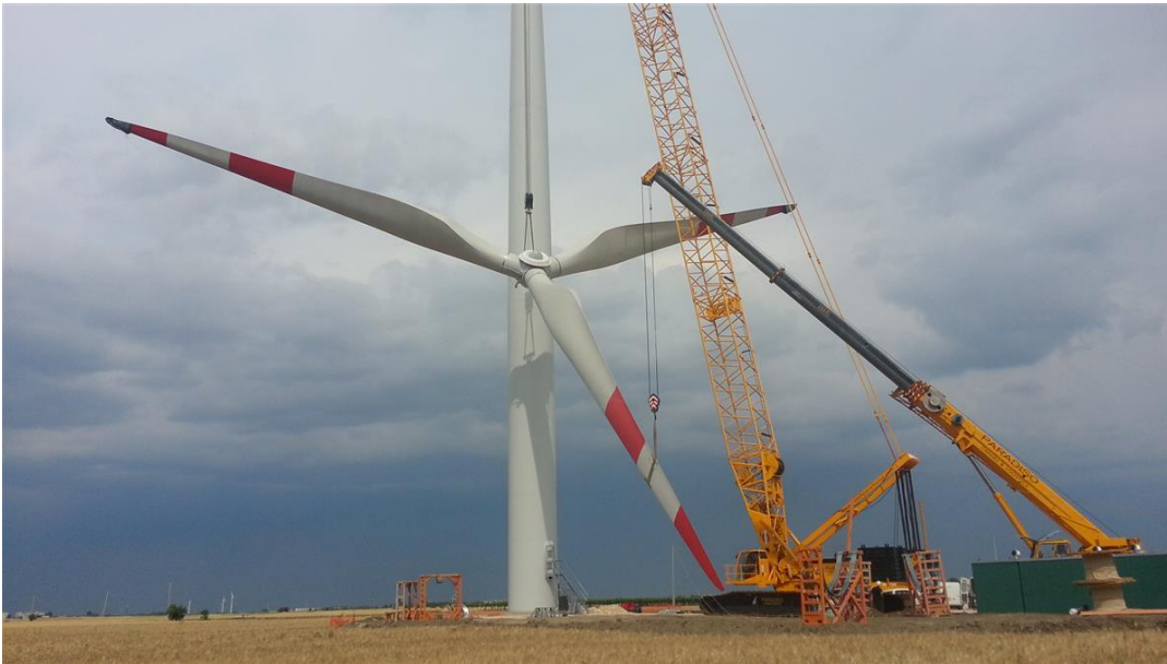
Figura 2. Smontaggio delle pale
