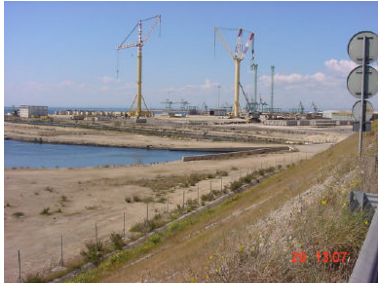
FOTO 15 - vista lato canale Ilva
