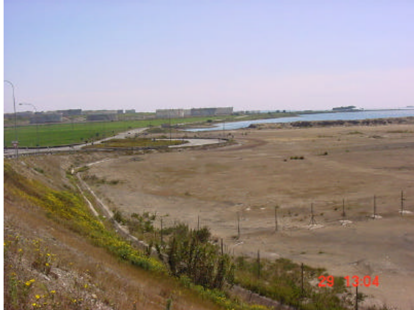
FOTO 13 - panoramica dalla sede stradale
