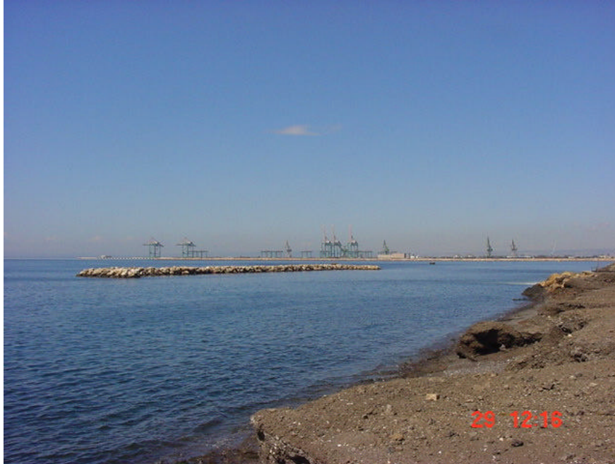
FOTO 5 - vista lato mare
