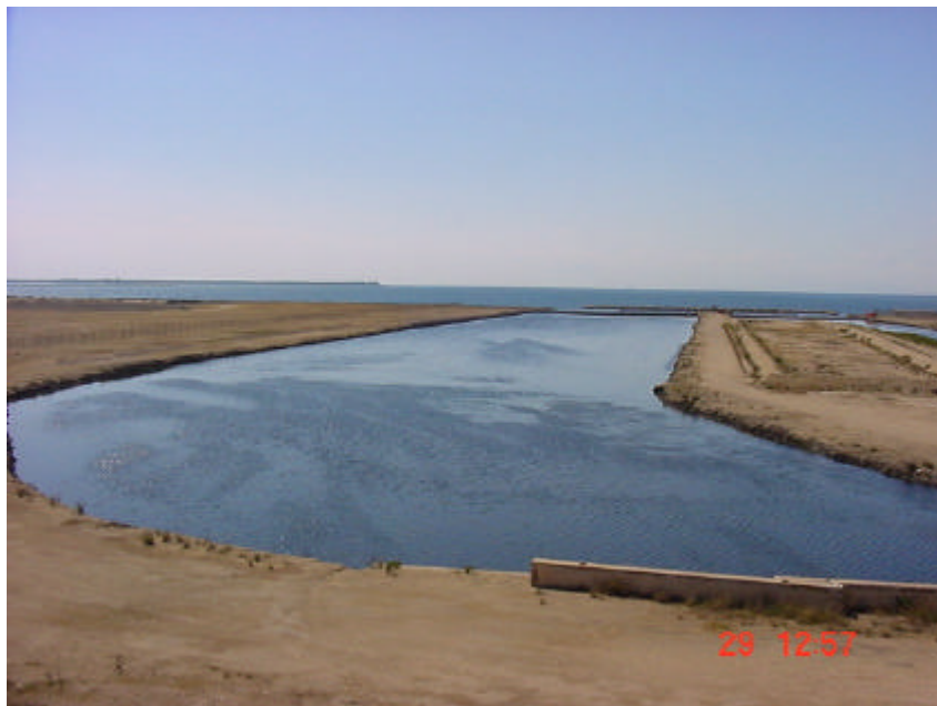
FOTO 10 - canale di scarico acqua Ilva
