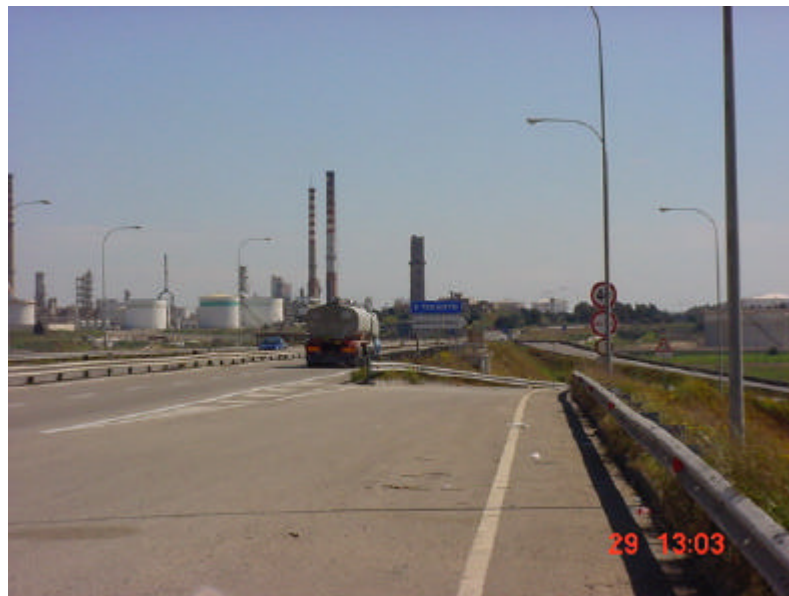
FOTO 14 - vista lungo la superstrada
