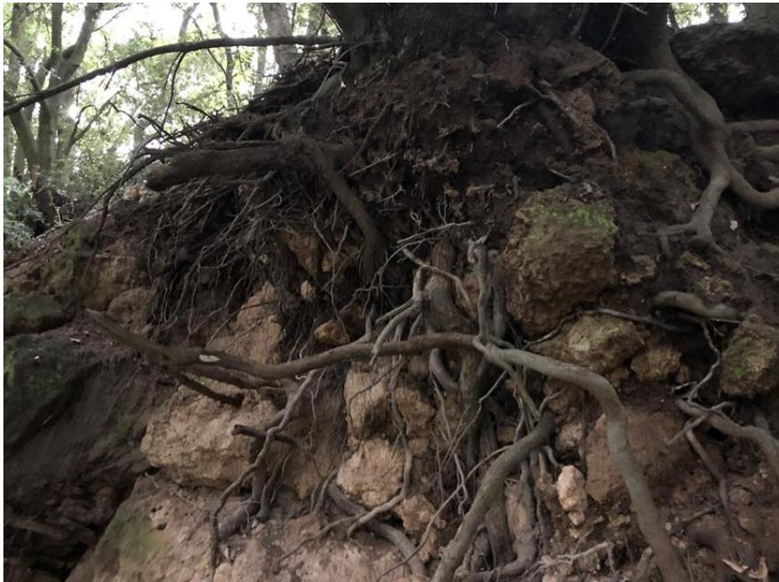
Figura 6: Sviluppo dell'apparato radicale all'interno dell'unità di Maddaloni, presente in testa e lungo la scarpata di monte. In evidenza lo sviluppo dell'apparato radicale che penetra lungo le fratture ed i vuoti presenti all'interno dei travertini.
