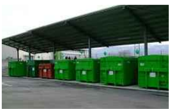
Predisposizione di Isola ecologica interna al cantiere
