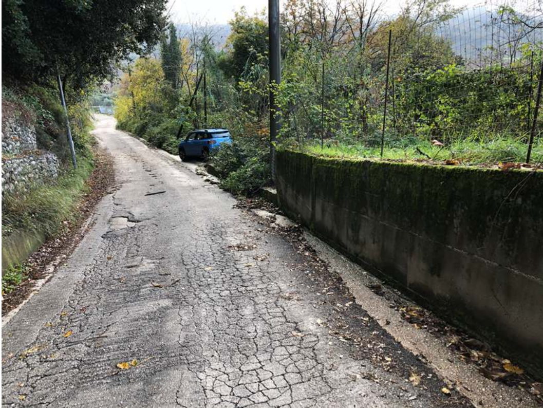
Figura 10: Vista verso valle dell'area instabile n.2 oggetto dello studio di dettaglio. In particolare, si evidenzia l'assenza di lesioni o crepe significative a livello del muro perimetrale esistente e del ciglio della pavimentazione stradale in prossimità del ciglio della scarpata.
