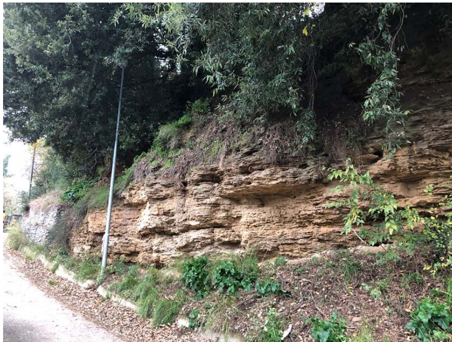
Figura 5: Affioramento tipo dei travertini dell'Unità di Maddaloni (MDL4). In evidenza le nicchie dei distacchi dei blocchi e le cavità generate dai processi erosivi lungo la scarpata.
