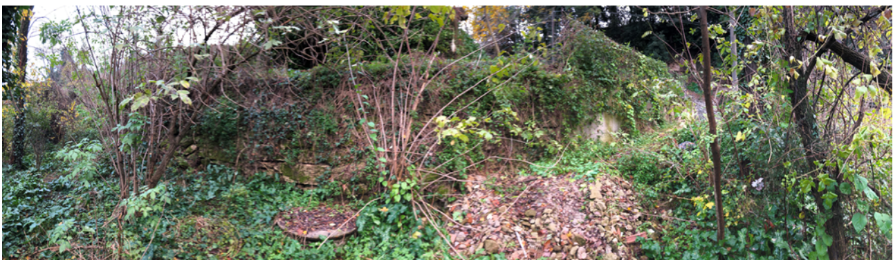
Figura 9: Parte terminale del muro di contenimento a ridosso del deposito antropico presente a lato della pavimentazione stradale.
