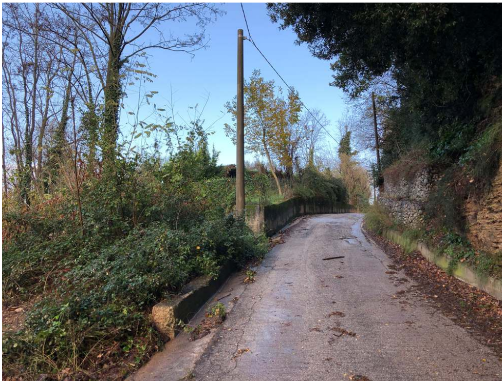
Figura 8: Vista verso monte dell'area instabile n.2 oggetto dello studio di dettaglio.
