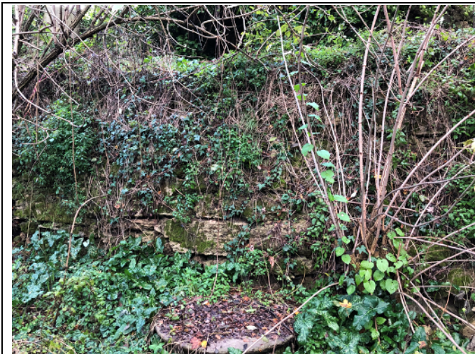
Figura 10: Vista verso valle dell'area instabile n.2 oggetto dello studio di dettaglio. In particolare, si evidenzia l'assenza di lesioni o crepe significative a livello del muro perimetrale esistente e del ciglio della pavimentazione stradale in prossimità del ciglio della scarpata.
