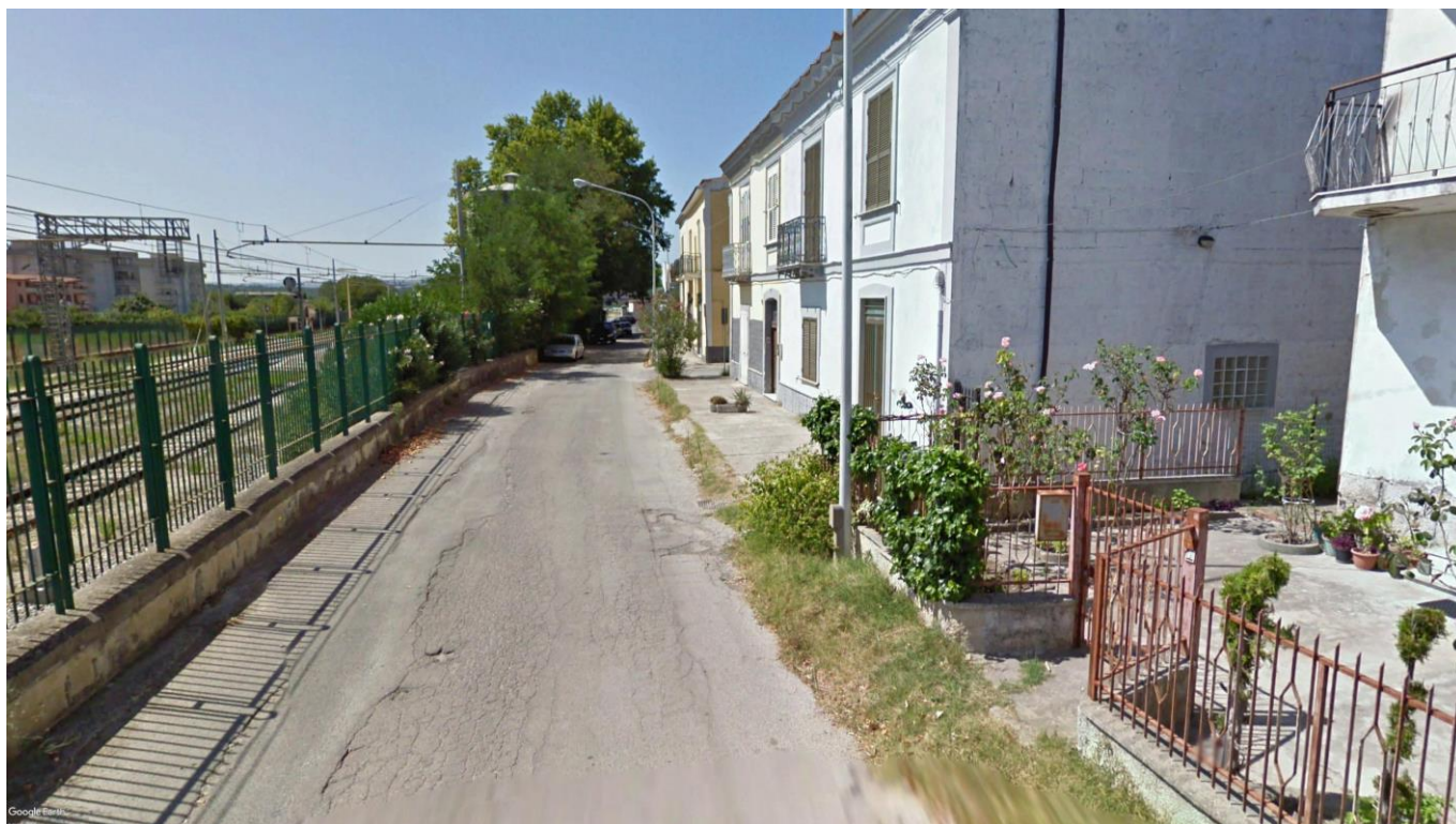
Figura 17: Vista ante operam della zona in prossimità del F.V. esistente
