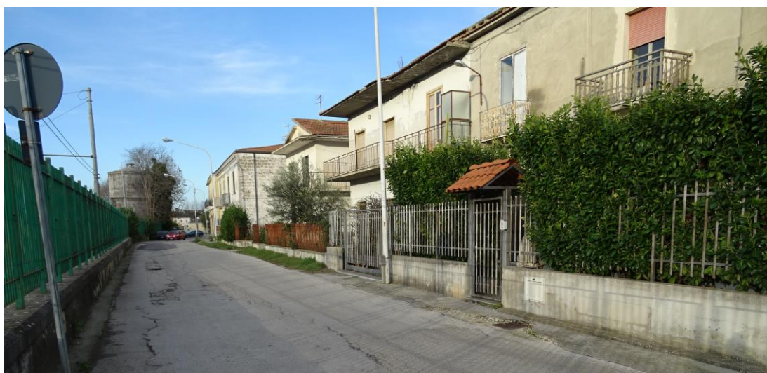
Figura 13: Vista ante operam
