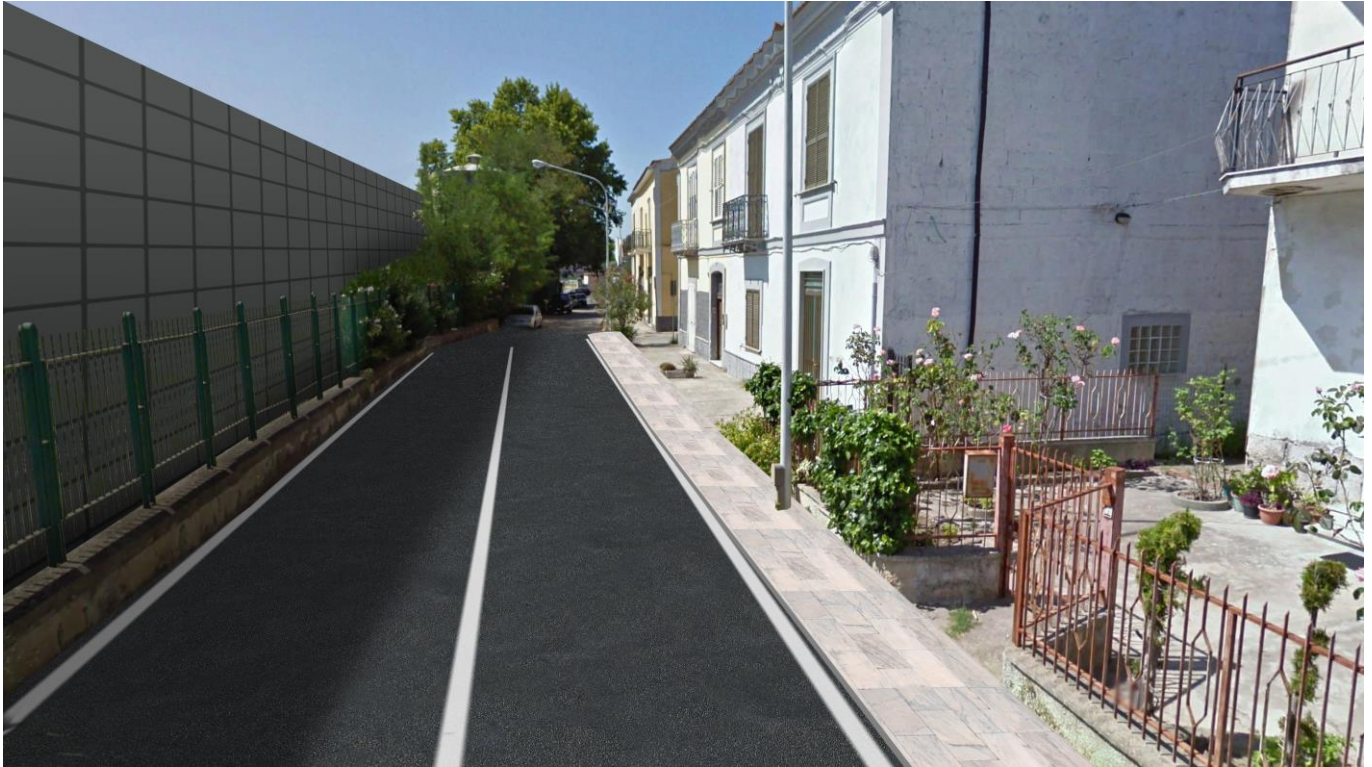
Figura 19: Vista post operam con inserimento della parete rivestita in G.F.R.C. su via ferrovia
