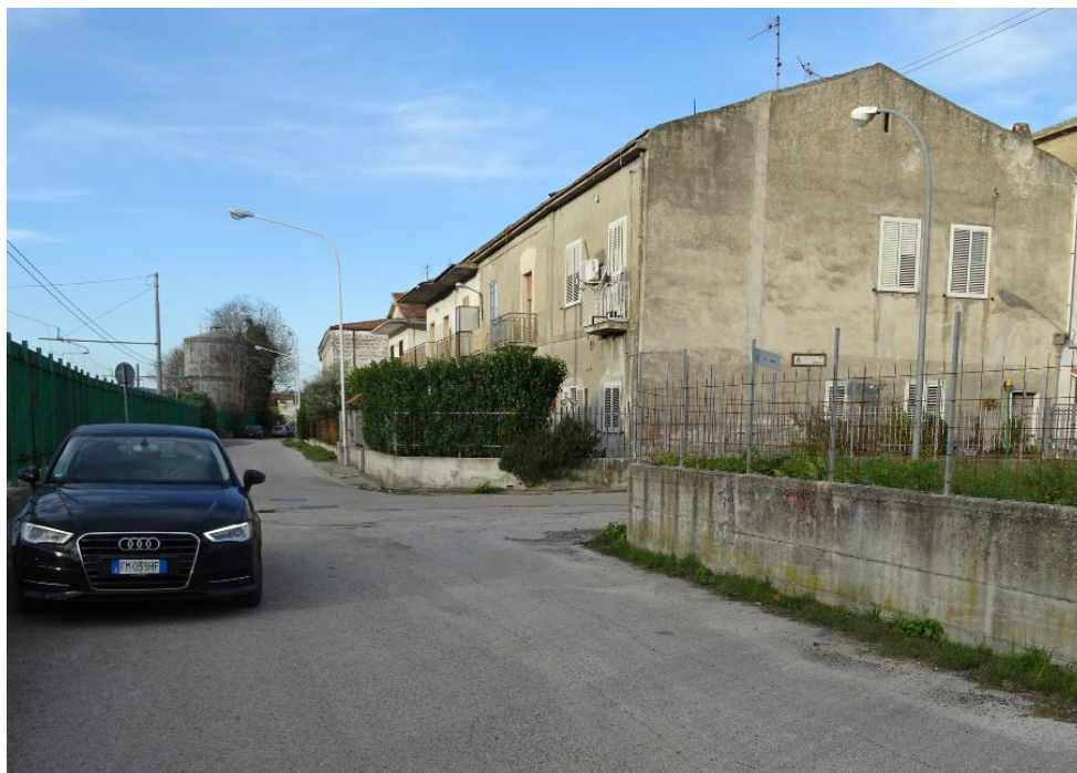
Figura 9: Terzo edificio sulla via Mazzini (dicembre 2019 - a sinistra la ferrovia e a destra l'incrocio con via Manzoni)
