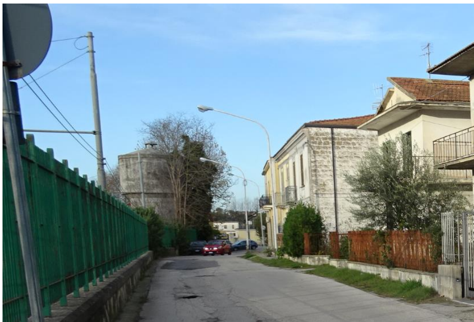
Figura 5: Secondo e primo edificio sulla via Mazzini (dicembre 2019 – a sinistra la ferrovia)
