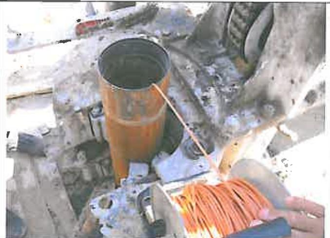
**Foto 15** – Sondaggio SI44 piezometro
