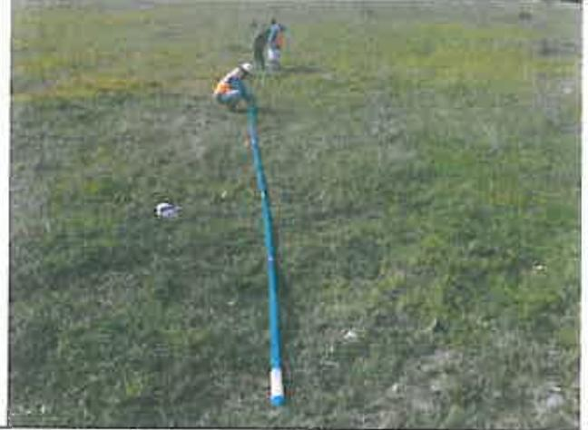
**Foto 27** – Sondaggio SI41 Installazione Piezometro Casagrande
