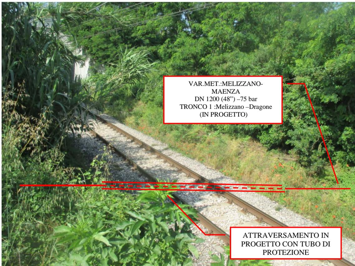
**Foto 3 – Vista dell’attraversamento della Ferrovia esistente NA-FG**
