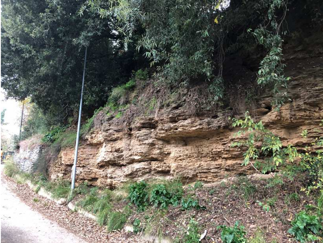
Foto 15 – Fenomeni di crollo e toppling s.l. che interessano i termini le scarpate della litofacies dei travertini della formazione di Maddaloni.
