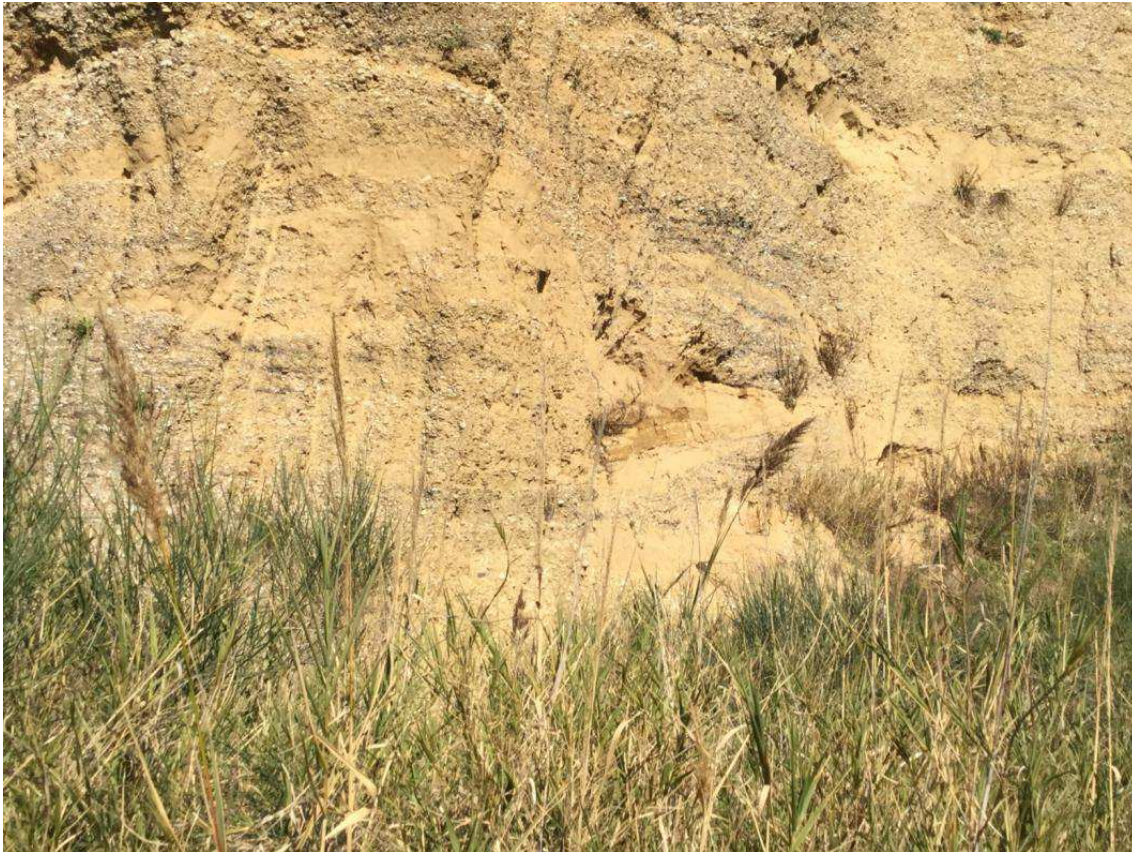
Figura 11 – Affioramenti dei Depositi alluvionali terrazzati ghiaioso-sabbiosi (bn1) con lenti di sabbie limose, in località Toppo Limata, a SSW del centro abitato di S. Lorenzo Maggiore.
