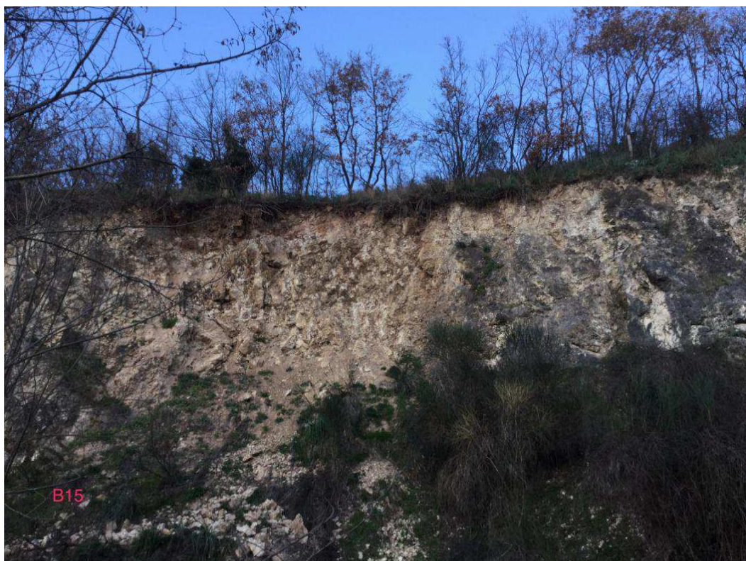
Figura 15 – Fenomeni di crollo s.l. che interessano i termini calcareo-marnosi delle Argille Varicolori Superiori.
