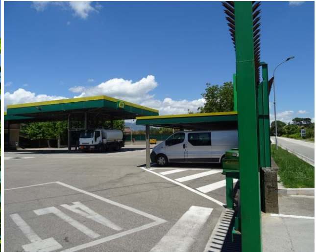
Edificio (tettoia) 3021B
