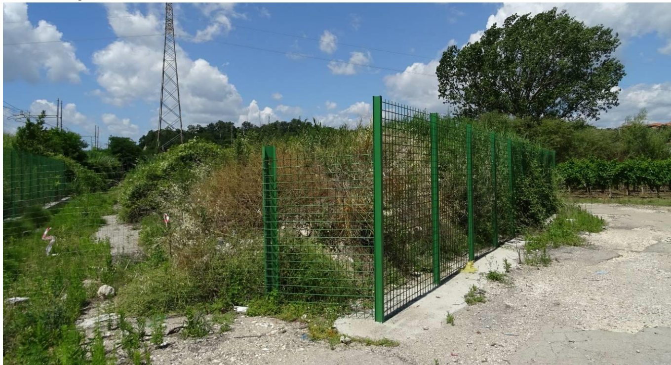
Foto 1 – Il sito della discarica abusiva nella futura SSE di Telese
