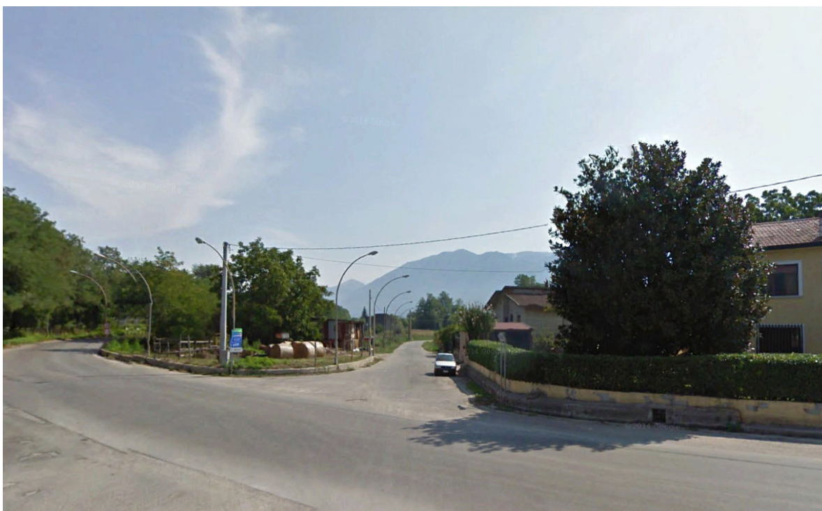
Figura 13: Intersezione tra Via Stazione e la S.P13-Via Napoli: assenza di segnaletica
