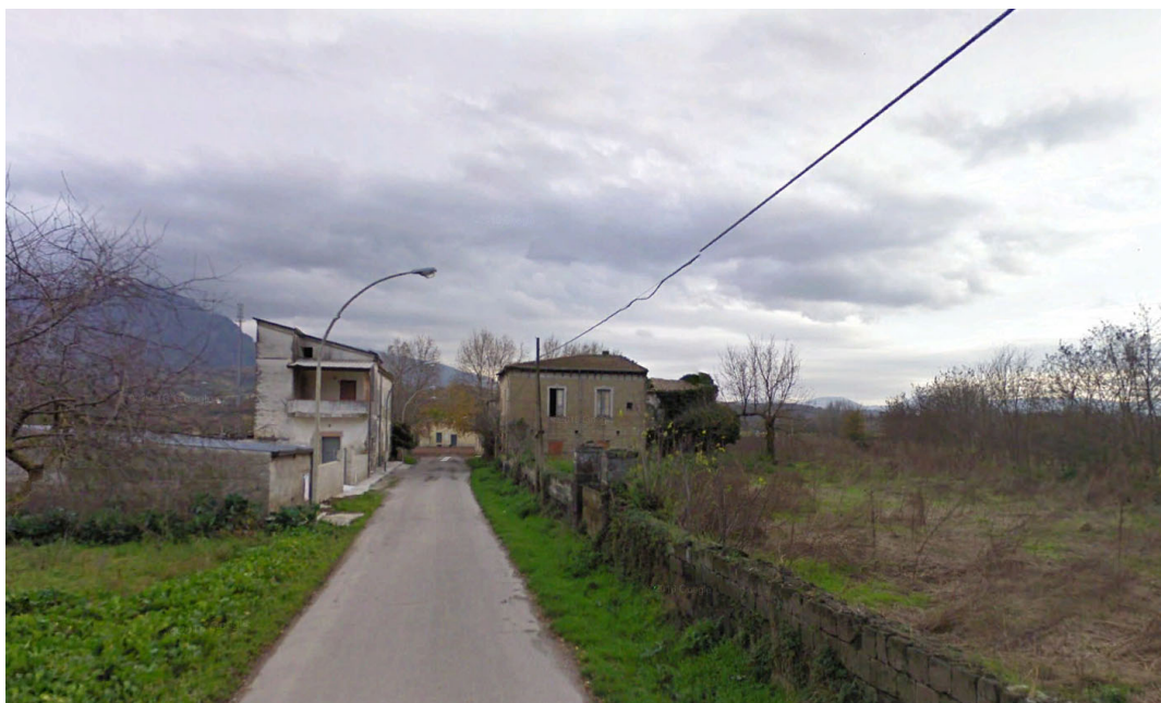
Figura 14: Assenza di segnaletica e di marciapiedi
