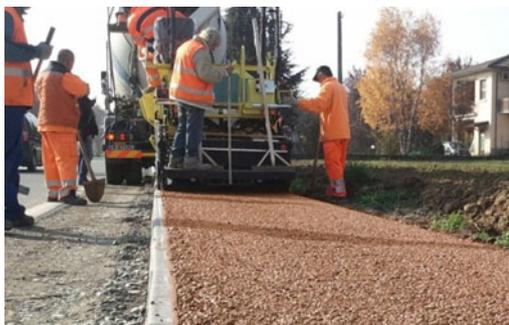
Figura 8: Pavimentazione pista ciclopedonale
