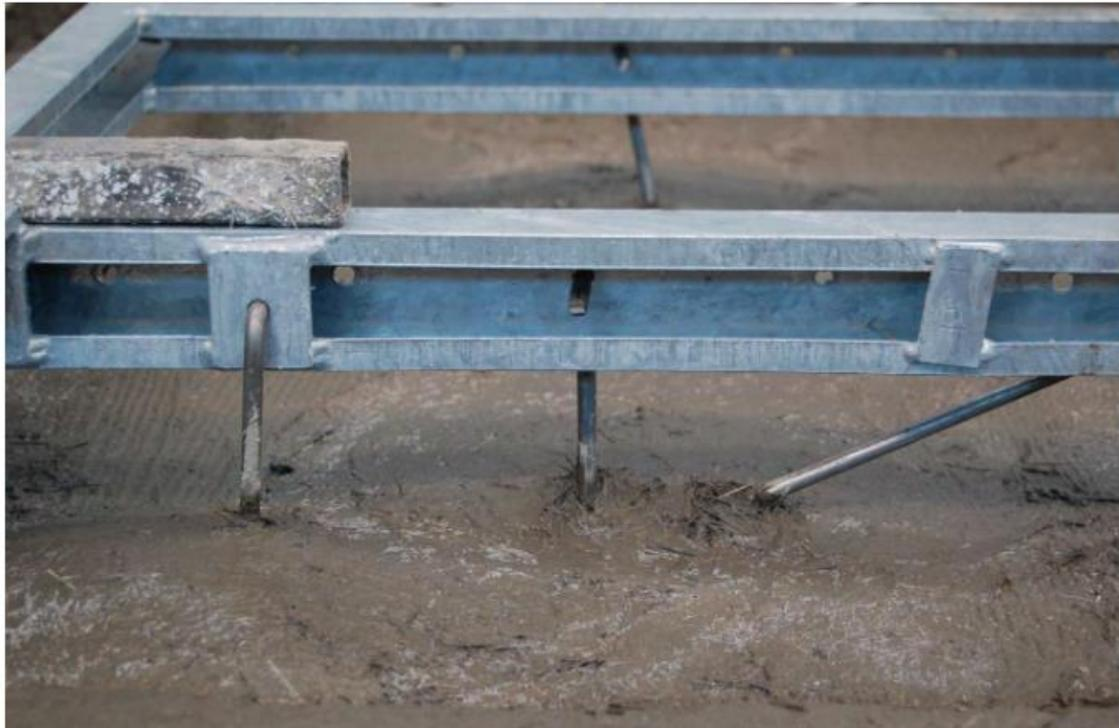
**Esempio di connessione pannello-telaio**
