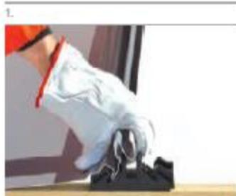
Una volta agganciata la lastra alla prima fila di staffe, posizionare la seconda fila di staffe sul lato libero della lastra (lato canale di drenaggio per Riverclack® 500 e Riverclack® 550 e lato inferiore della greca per Riverclack® Grip 600) con una semplice pressione.
