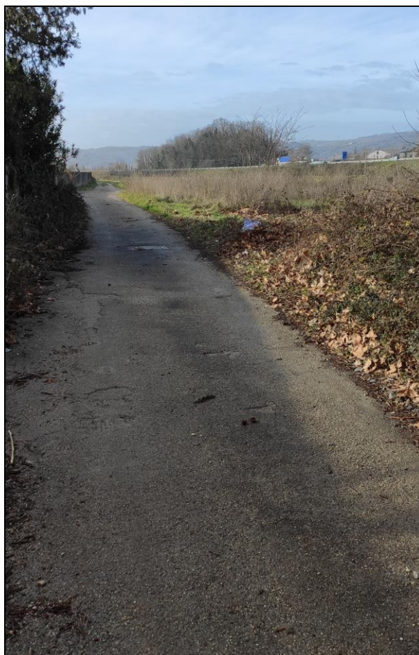
Strada con Cavidotto Interrato BT
