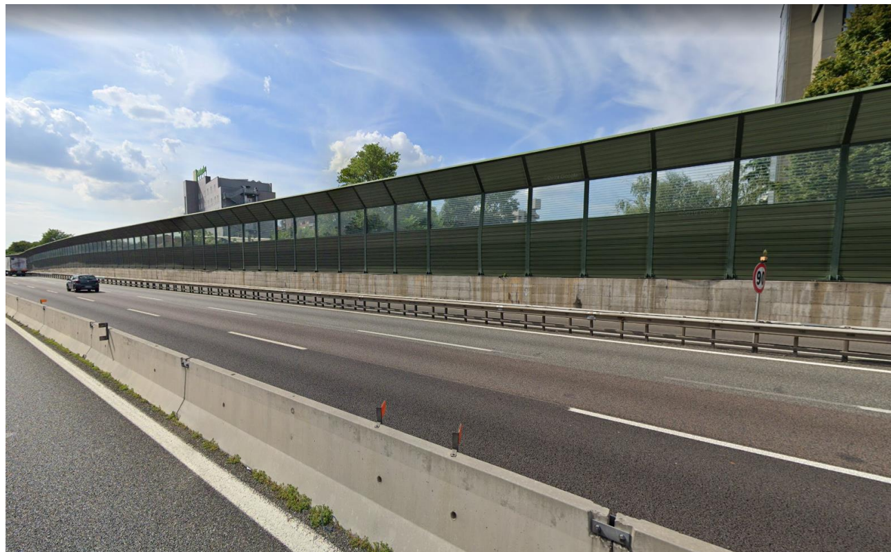
Figura 4-26. Barriera Piano di risanamento acustico n. 12. Vista in direzione ovest
