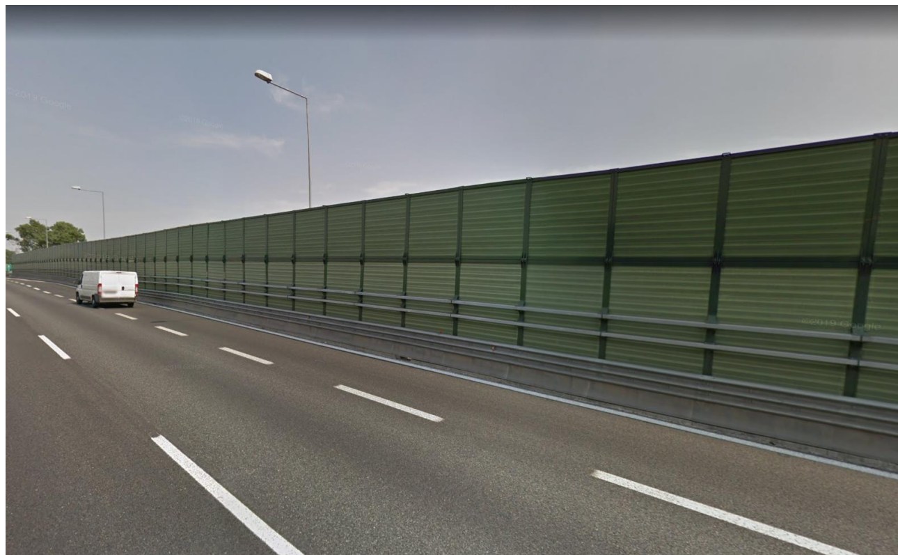
Figura 4-27. Barriera Piano di risanamento acustico n. 13. Vista in direzione est
