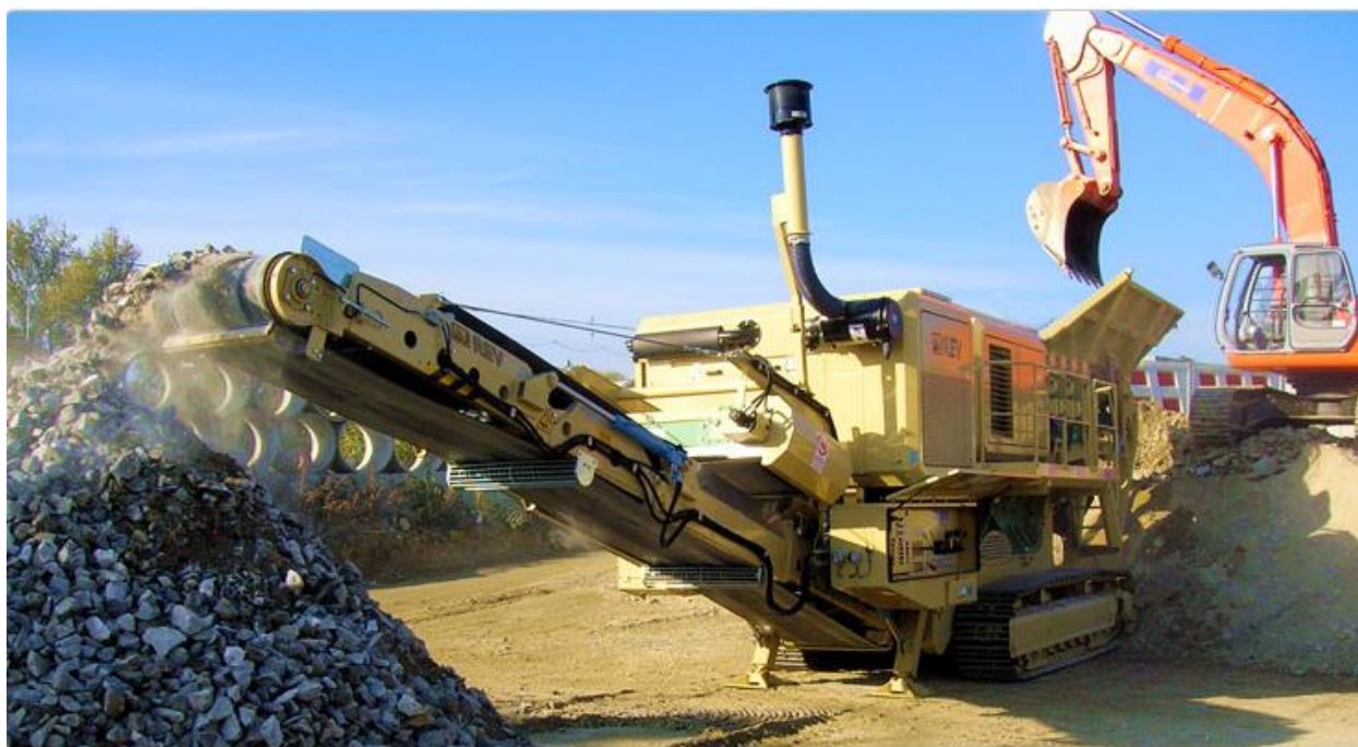
Figura 5.13 – Tipico frantoio mobile per il riutilizzo in sito delle rocce da scavo
