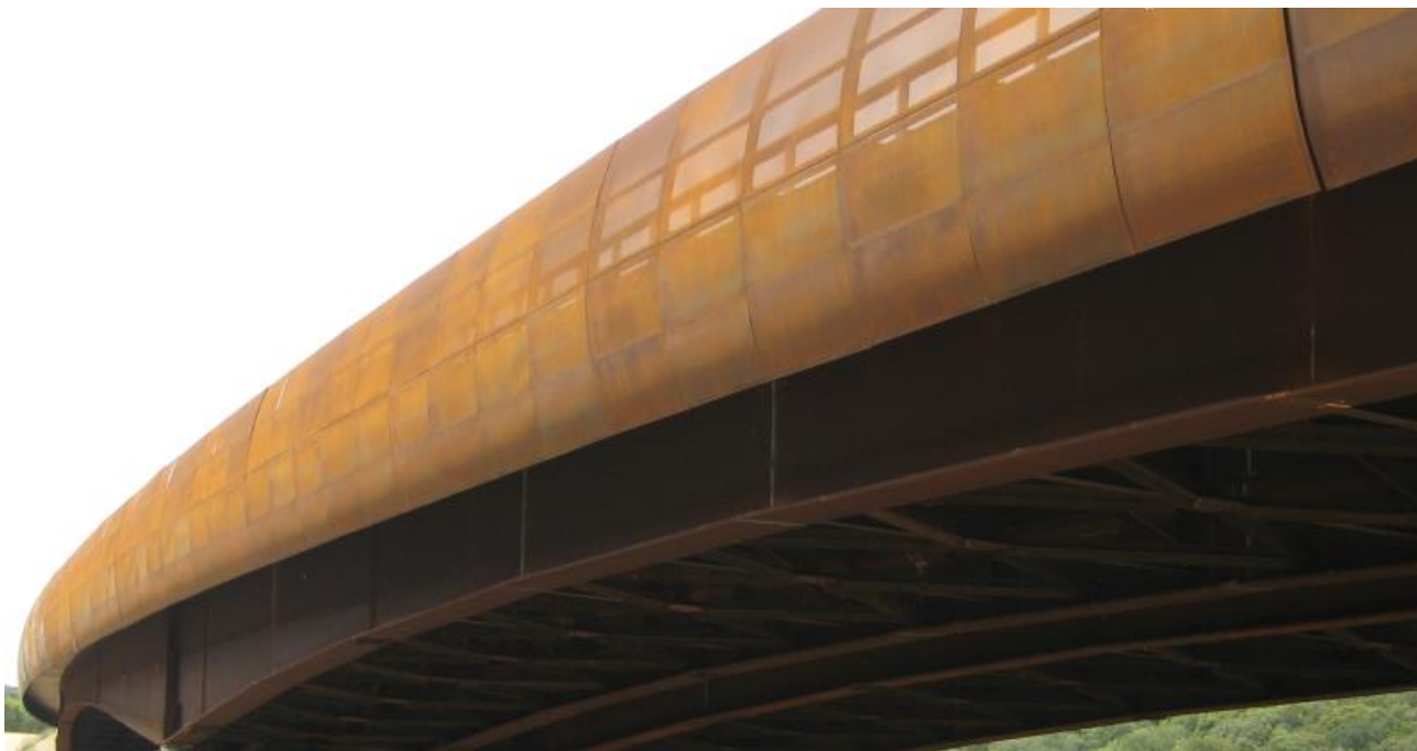
Figura 30: Esempio di carter in lamiera corten microforata
