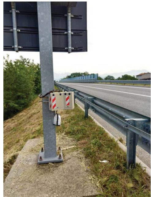
Installazione - direzione B
