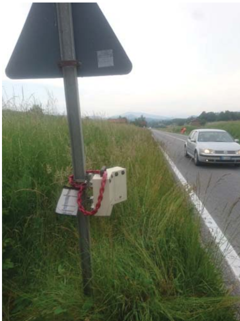
Installazione - direzione A
