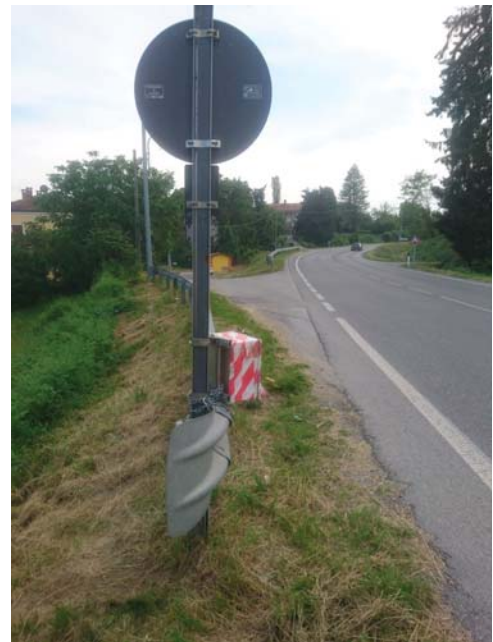
Installazione - direzione B
