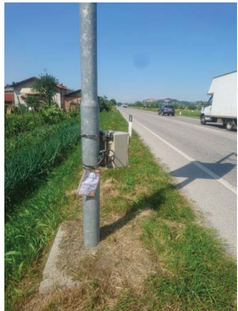
Installazione - direzione B
