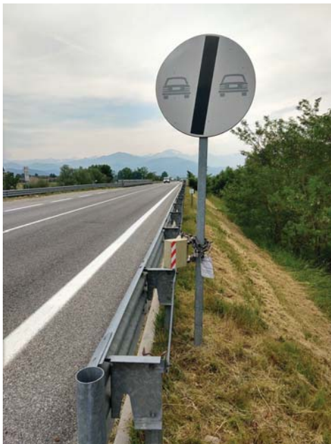
Installazione - direzione A
