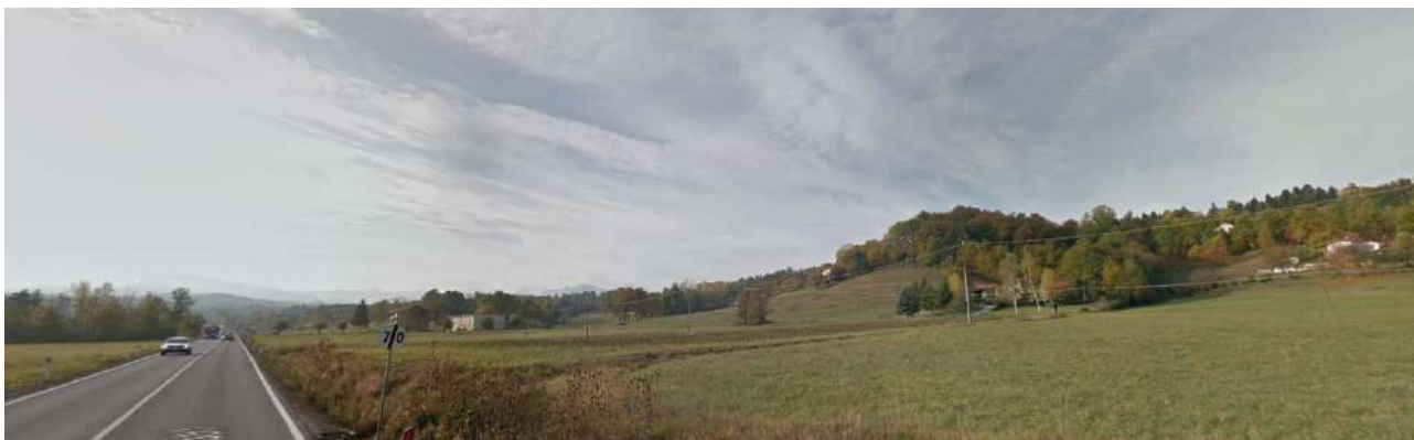
Figura 2-242 - Rotonda di connessione con la SS28 ed imbocco della galleria S Lorenzo: interscambio relativo alle zone immediatamente adiacenti l'area di intervento
