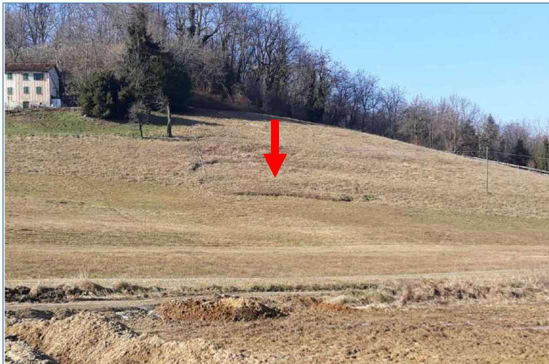
Figura 2-171 Versante orientale della Collina di S. Lorenzo, in prossimità dell'imbocco est della galleria. Fenomeno deformativo superficiale. Sulla sinistra dell'immagine Cascina Rigata
