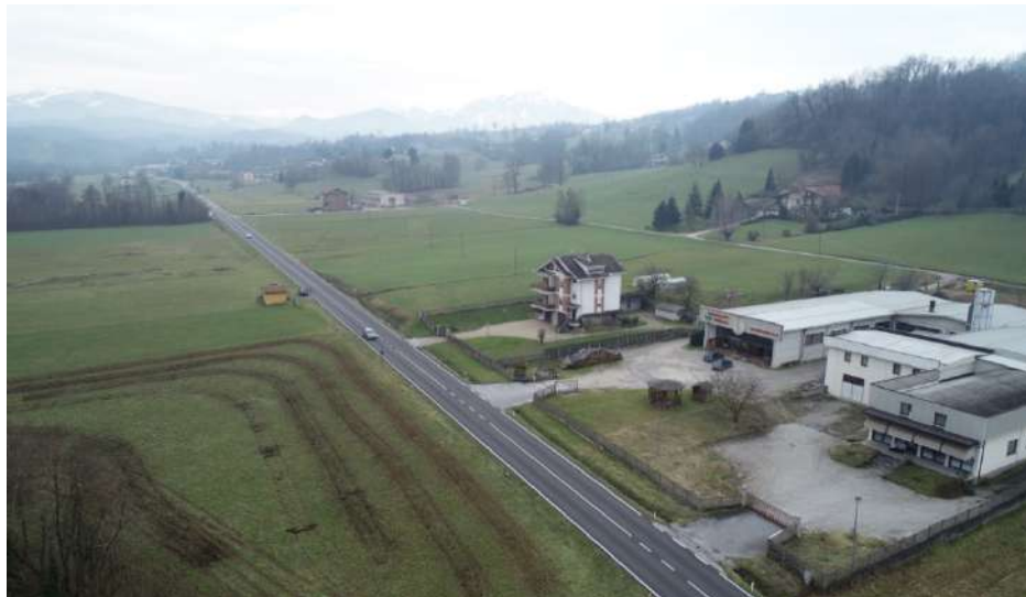
Figura 2.217 Innesto su SS28: tessitura agraria con appezzamenti di piccola dimensione
