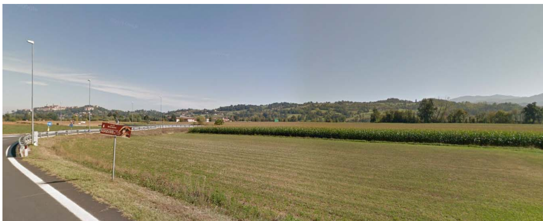
Figura 7.2 – Tratto compreso tra la rotonda di connessione con la SP 5 e l'inizio viadotto Ellero: intervisibilità limitata alle zone di pertinenza delle aree agricole
