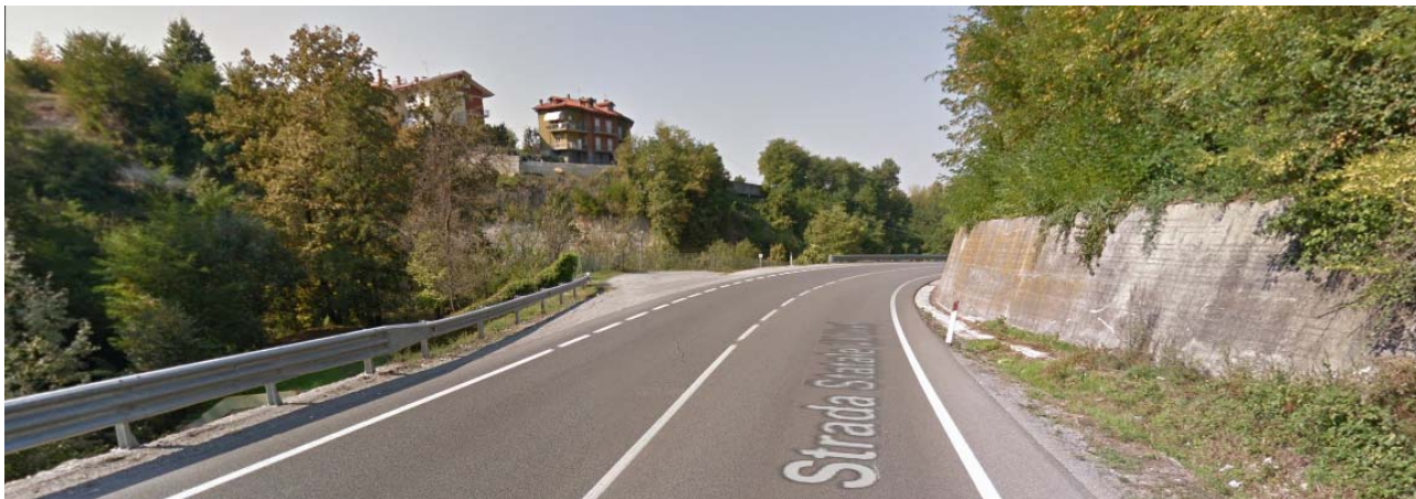
Figura 6.18 Viadotto Ermeno: intervisibilità limitata all'area strettamente adiacente l'intervento
