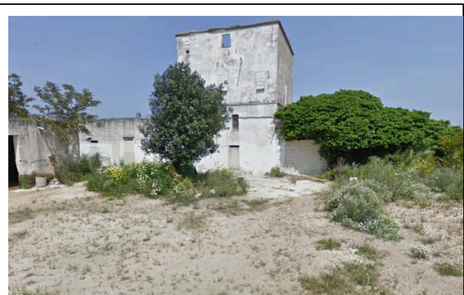
Vista dalla strada comunale
