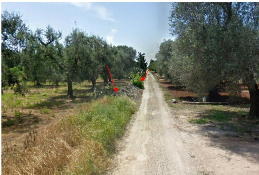
Muro a secco (9bis) interessato da rimozione temporanea e rifacimento a fine cantiere
