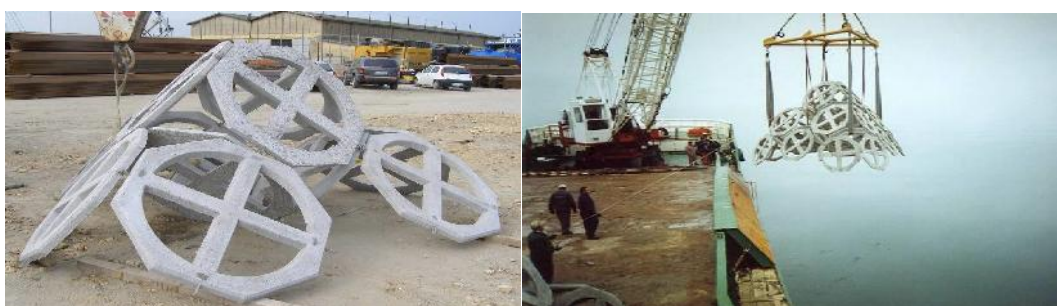
Sollevamento dei moduli
