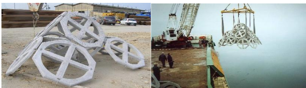
Sollevamento dei moduli
