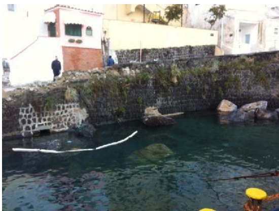
Vista stralcio muro interno alla Marina
