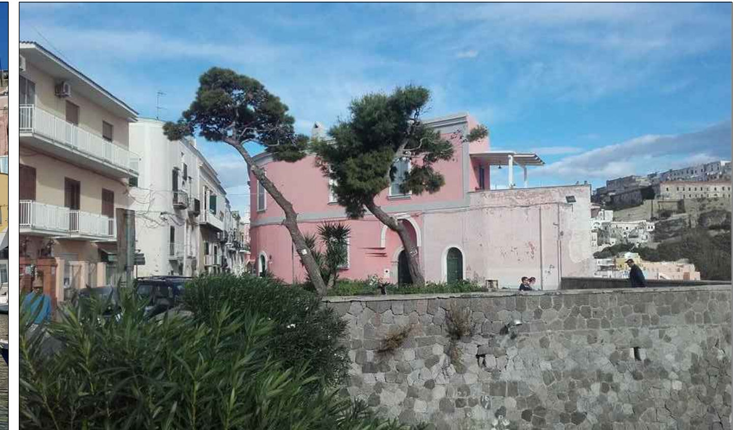
F2: Muro del belvedere dalla scala
