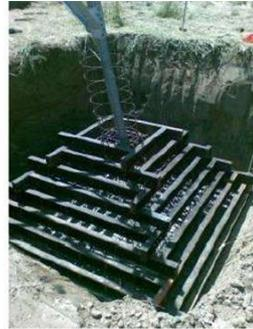
**Fig. 7: Esempio di realizzazione di una fondazione a plinto con riseghe. Nell'immagine si può osservare un disegno di progetto mentre nell'immagine di destra la fase di casseratura della fondazione.**
