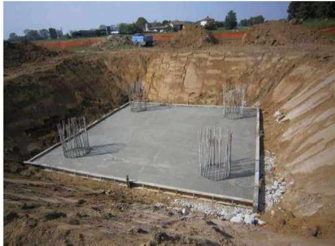
**Fig 9: Realizzazione di una fondazione su pali trivellati per un sostegno monostelo. Nell'immagine si può osservare una fondazione in fase di realizzazione. Si possono distinguere facilmente i quattro pali trivellati già realizzati e gettati (si osservano le prese delle quattro gabbie metalliche) e del piano di magrone sul quale impostare il monoblocco in cls.**
