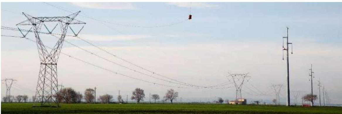
**Fig. 10 Utilizzo dell'elicottero per la stesura della fune pilota**
