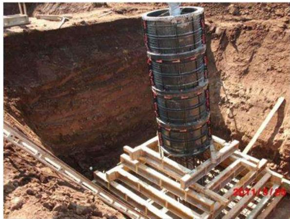
**Fig. 8: Esempio di realizzazione di fondazioni superficiali tipo CR per un sostegno a traliccio. Nell'immagine si può osservare la fase di casseratura.**
