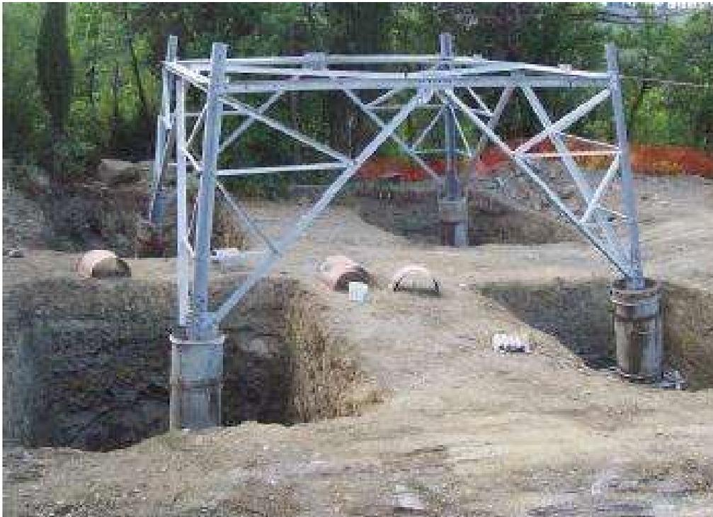
**Fig. 6** Realizzazione di fondazioni superficiali tipo CR per un sostegno a traliccio. Nell'immagine si possono osservare le quattro buche, la base del sostegno collegata alla fondazione tramite i "monconi" ed i casseri utilizzati per quattro "colonnini"
