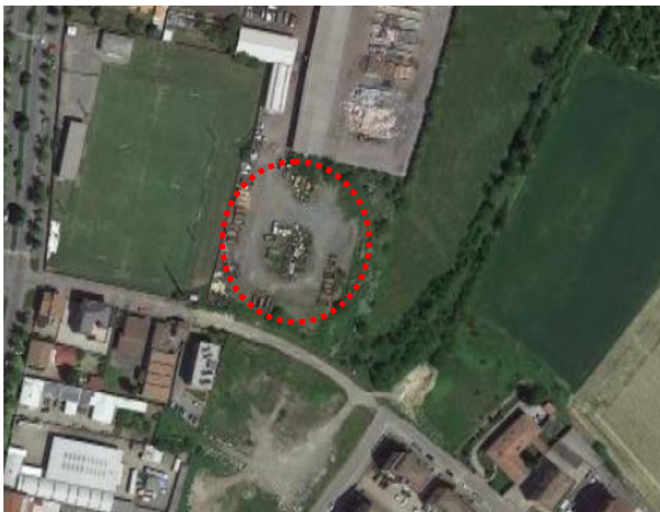
Figura 3.3 Area di prevista localizzazione della Centrale Nord – Vista aerea
