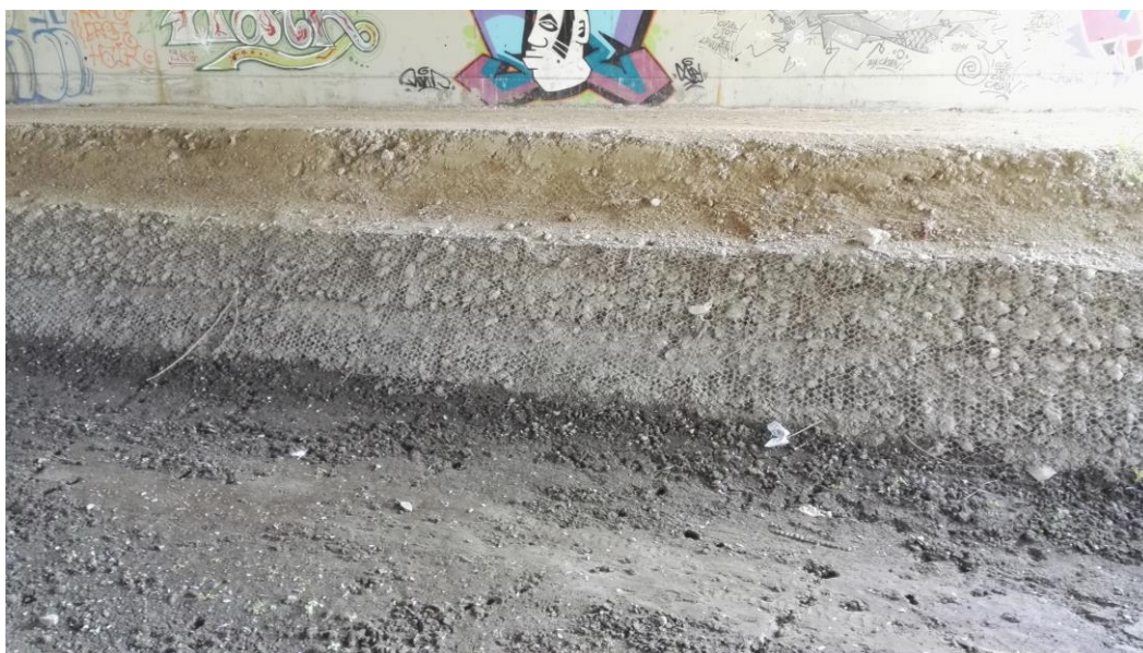
Figura 22 – sistemazione spondale esistente in corrispondenza dell'impalcato.
