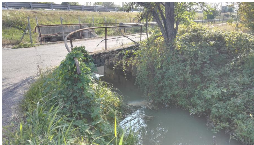
Figura 10 - ponticello a valle dell'attraversamento autostradale.
