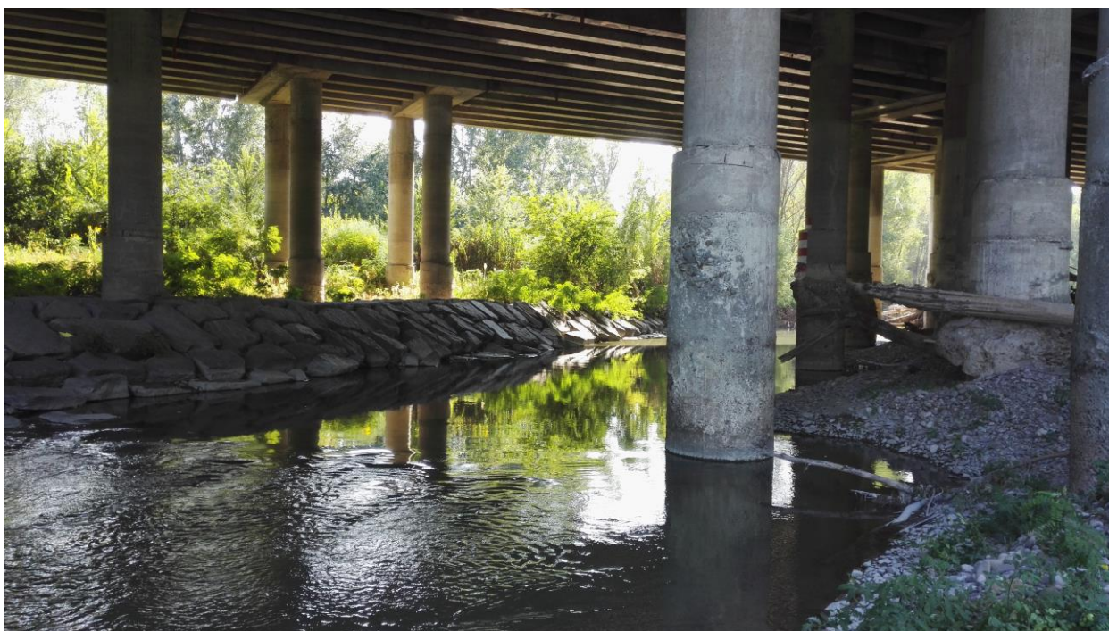
Figura 37 – scogliera in massi attualmente presente in corrispondenza dell'impalcato
