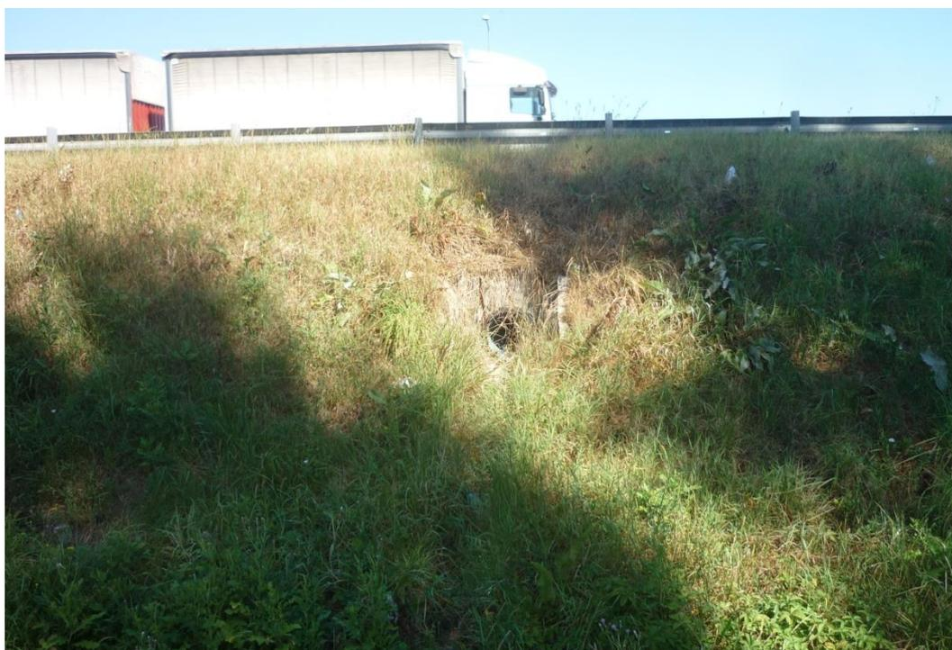
Figura 4-18: Esempio di manufatto di sbocco tubazione trasversale di convogliamento acque di piattaforma A14.
