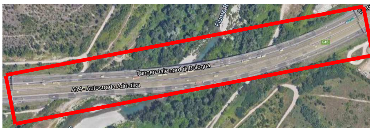
Viadotto Reno – Stato di fatto – A14 Km 9+925
