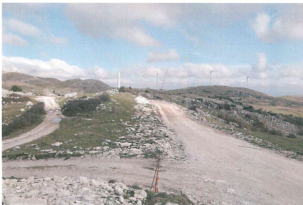
Foto 4/4 bis - Alterazione del paesaggio, con costruzione di nuove piste con larghezza variabile da 6 a 12 metri e oltre nelle curve, abbandono del vecchio tracciato sterrato e scavi e depositi di materiali inerti di diversa provenienza ai lati delle piste con distruzione (asportazione, seppellimento o rimaneggiamento) degli habitat di Direttiva 6110*, 6210 e, potenzialmente, 6210*.
