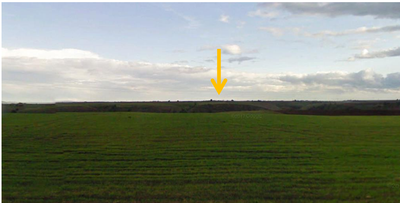
Figura 2-4: Vista turbina WTG 1
