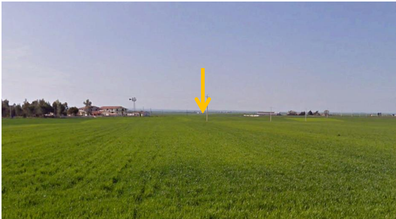
Figura 2-10: Vista turbina WTG 7
