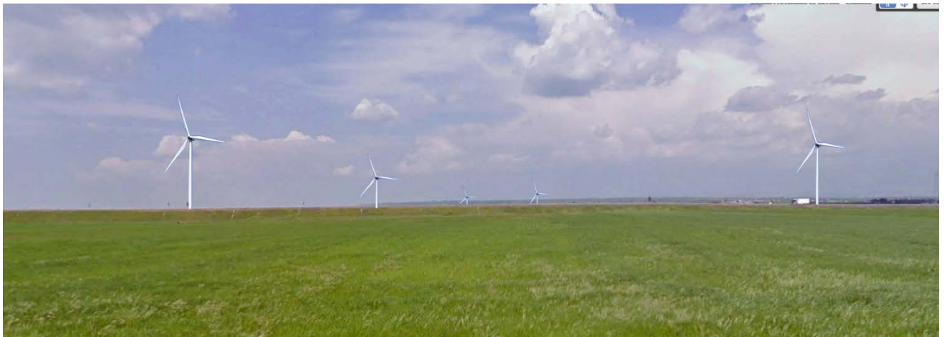
Fig. 3-10: Panoramica post operam da Masseria Trentangeli
