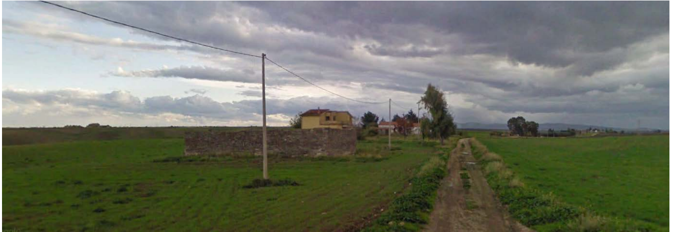
Fig. 3-17: Panoramica ante operam da Masseria Iannuzzo
