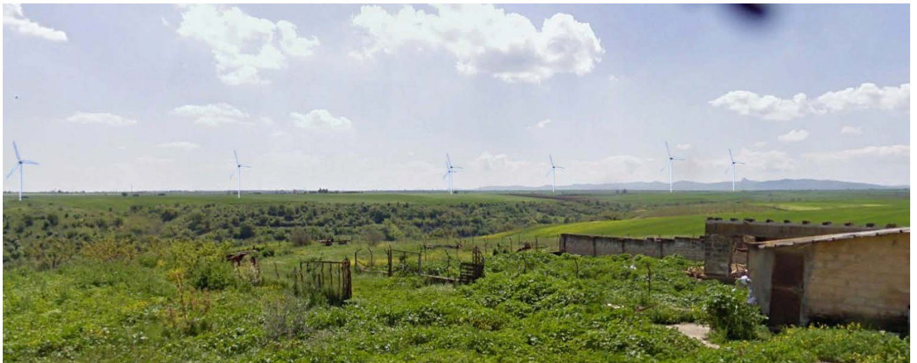
Fig. 3-16: Panoramica post operam da Masseria Bosco delle Rose
