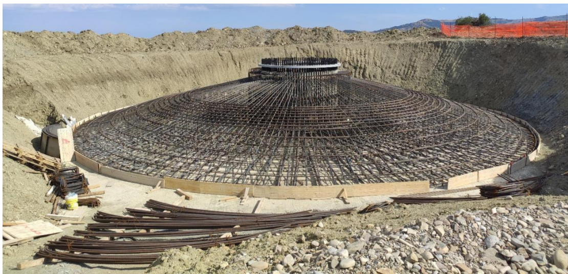
Figura 8: armatura plinto tipo
