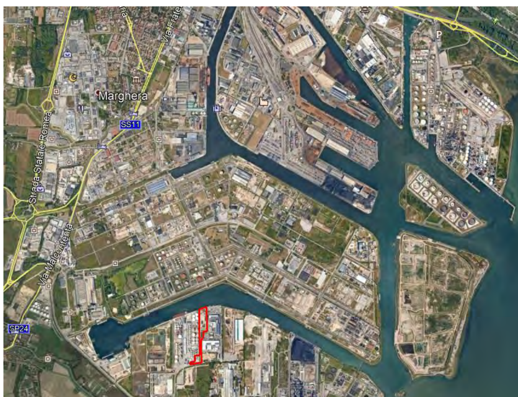
Fig. 2.1 – Localizzazione dell'area, in rosso il deposito GNL– (fonte Google Earth)
