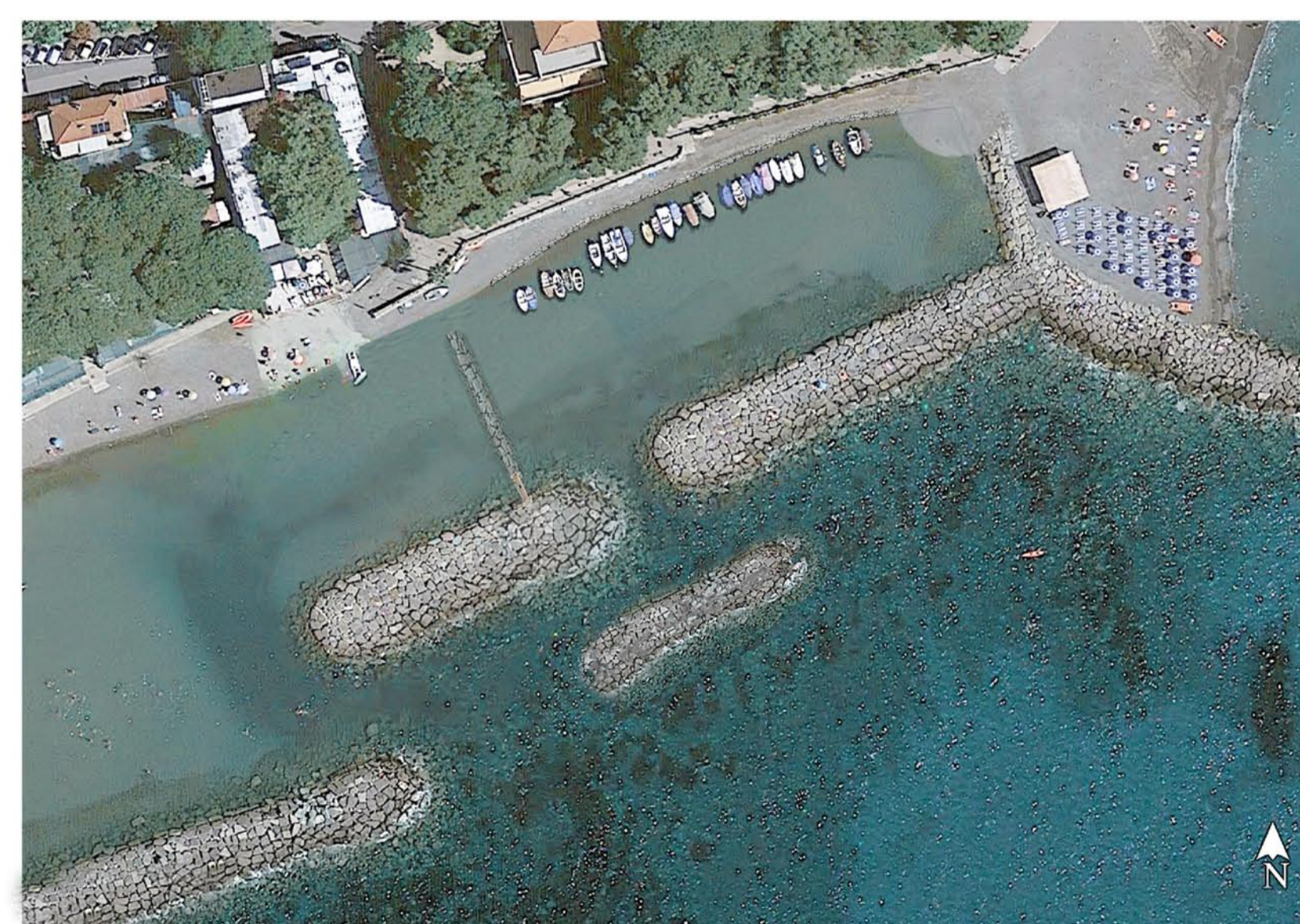
FOTOINSERIMENTO DI PROGETTO: in evidenza la separazione tra la porzione di litorale adibita al ricovero dei natanti e quella destinata alla balneazione, l'antemurale, di dimensione contenuta, costituisce un'efficace protezione alla nuova imboccatura della Darsena.
