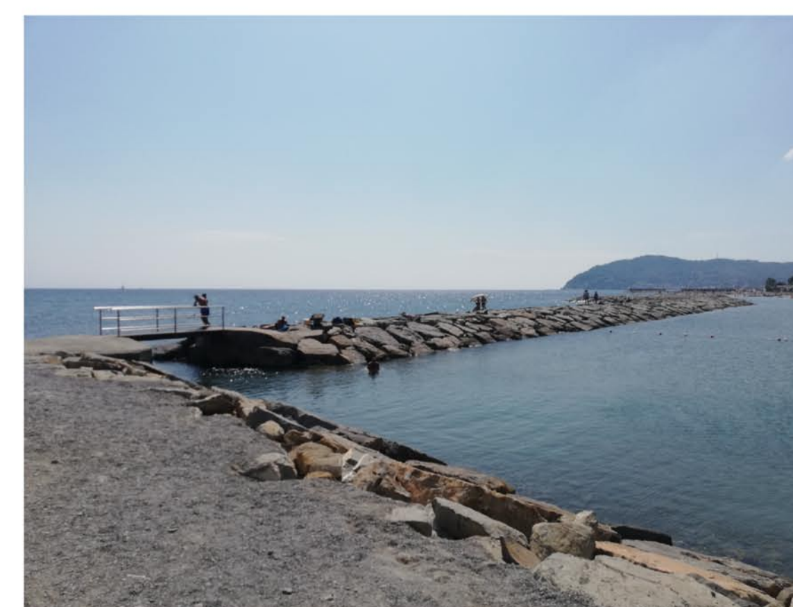
PRESA FOTOGRAFICA PI03: Vista del troncone di barriera di protezione della Darsena
