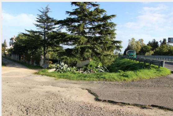
R03002006 Veduta da sud ovest.
