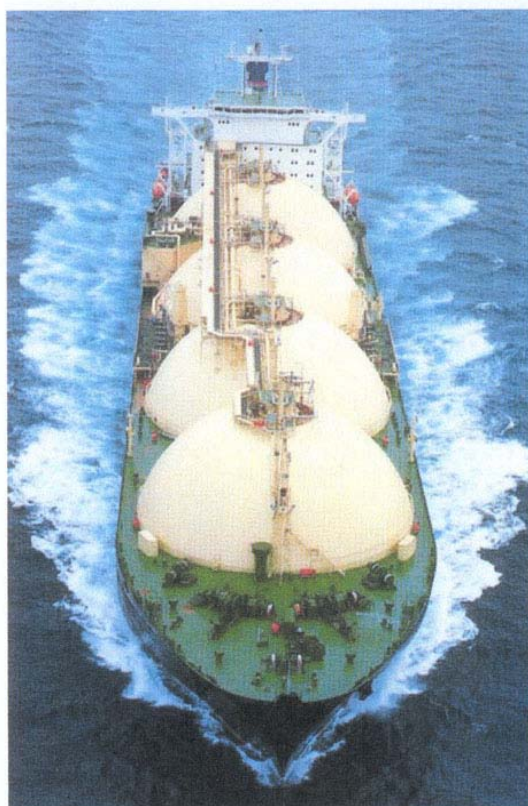
Fig. 8.2 - Esempio di nave metaniera con serbatoi sferici (tecnologia Moss-Rosenberg).
